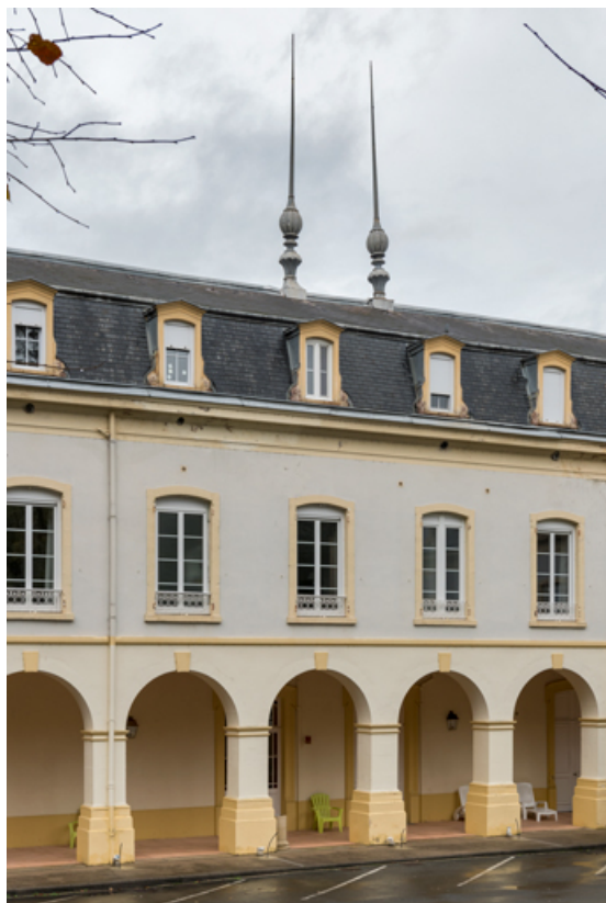
Cour, détail de l'aile nord.
