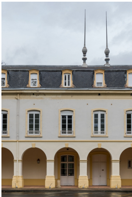
Cour, détail de l'aile nord.
