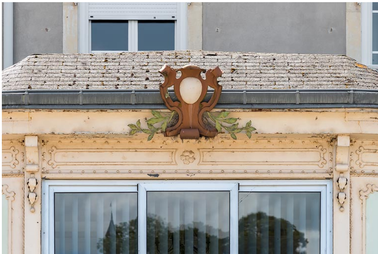
Aile ouest, salle à manger, détail.
