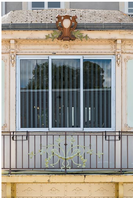
Aile ouest, salle à manger, détail.
