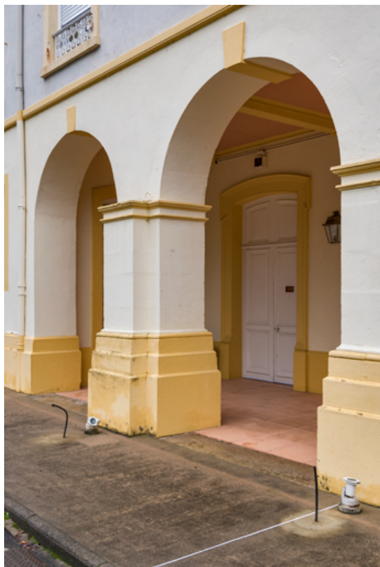
Cour, détail de l'aile nord (arcade en pierre à droite, arcade en ciment à gauche). 71, Bourbon-Lancy, 2 Parc thermal
