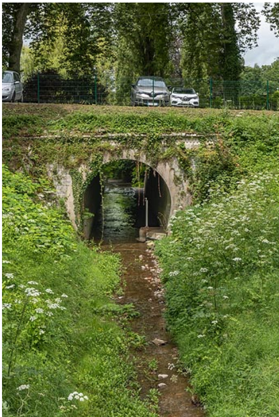
Tunnel du Borne sous l'allée d'Aligre.
