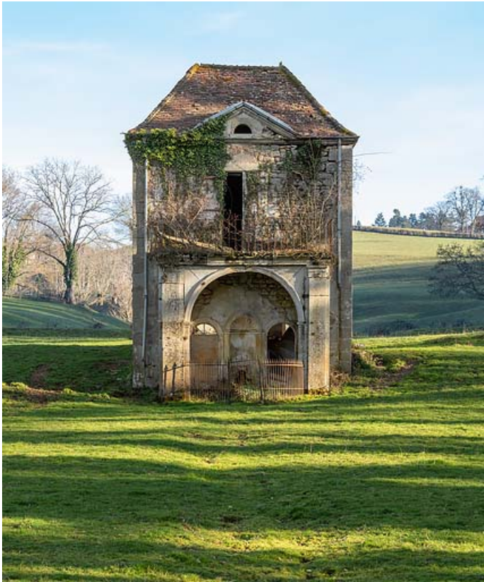
Pavillon de la source, vue de face.
