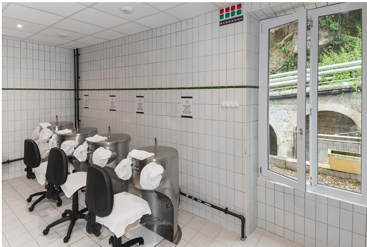
Étuves locales, au rez-de-chaussée (pavillon annexe de 1897).
