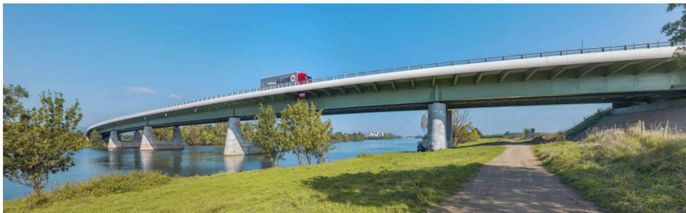
Pont supportant l'autoroute A 406, vu d'aval, depuis le chemin de halage rive gauche. 71, Varennes-lès-Mâcon, lieudit : PK 76,5
