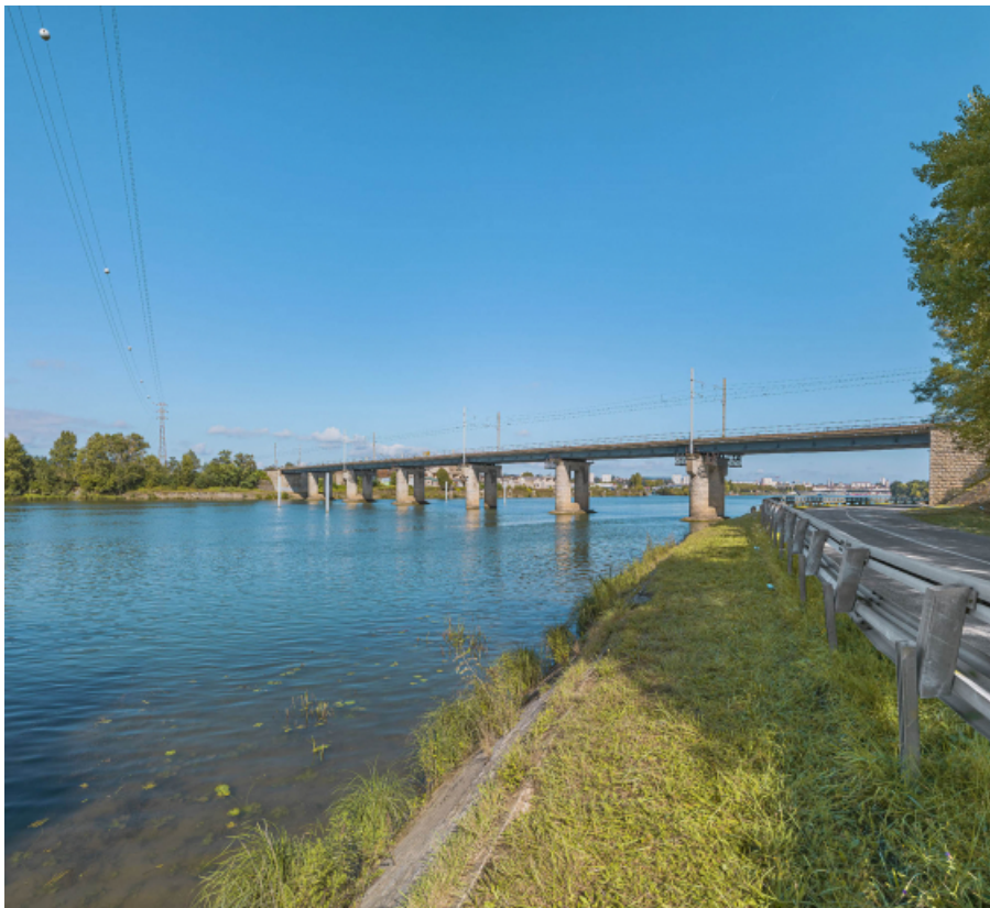
Le pont vu d'aval, rive gauche.
