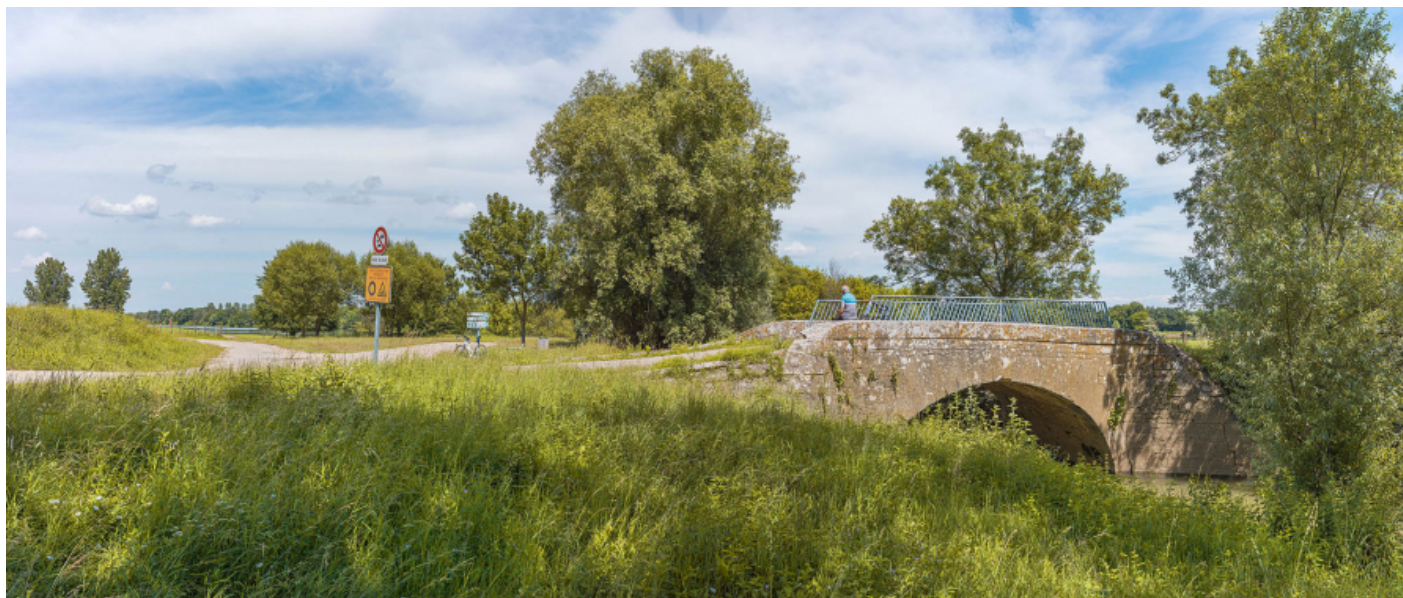
Le pont sur la Mouge, rive droite.
