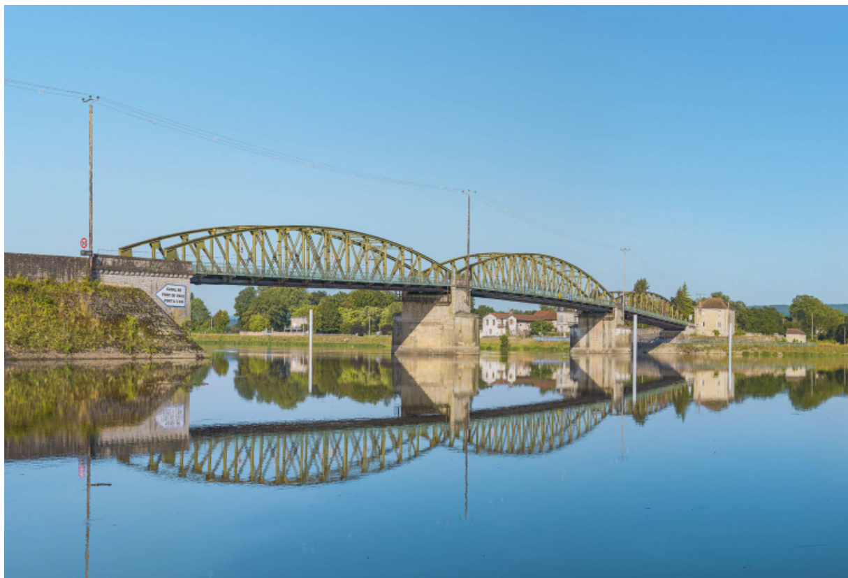
Le pont de Fleurville, vu d'amont, depuis la rive gauche.
