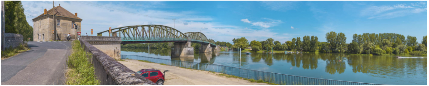
Le pont de Fleurville, vu d'aval, depuis la rive droite. La maison pontière se trouve au premier plan.
