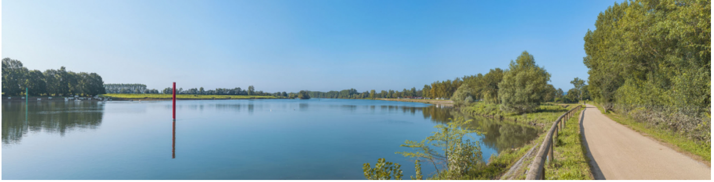
Le port d'Uchizy, vu d'amont. A droite, le chemin de halage/véloroute. 71, Uchizy, lieudit : PK 102,5
