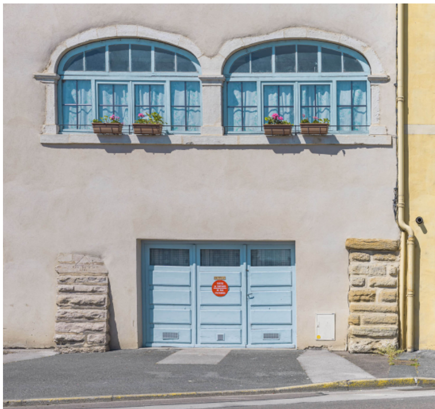
Repère de crue sur la façade d'une maison, quai du Midi. 71, Tournus
