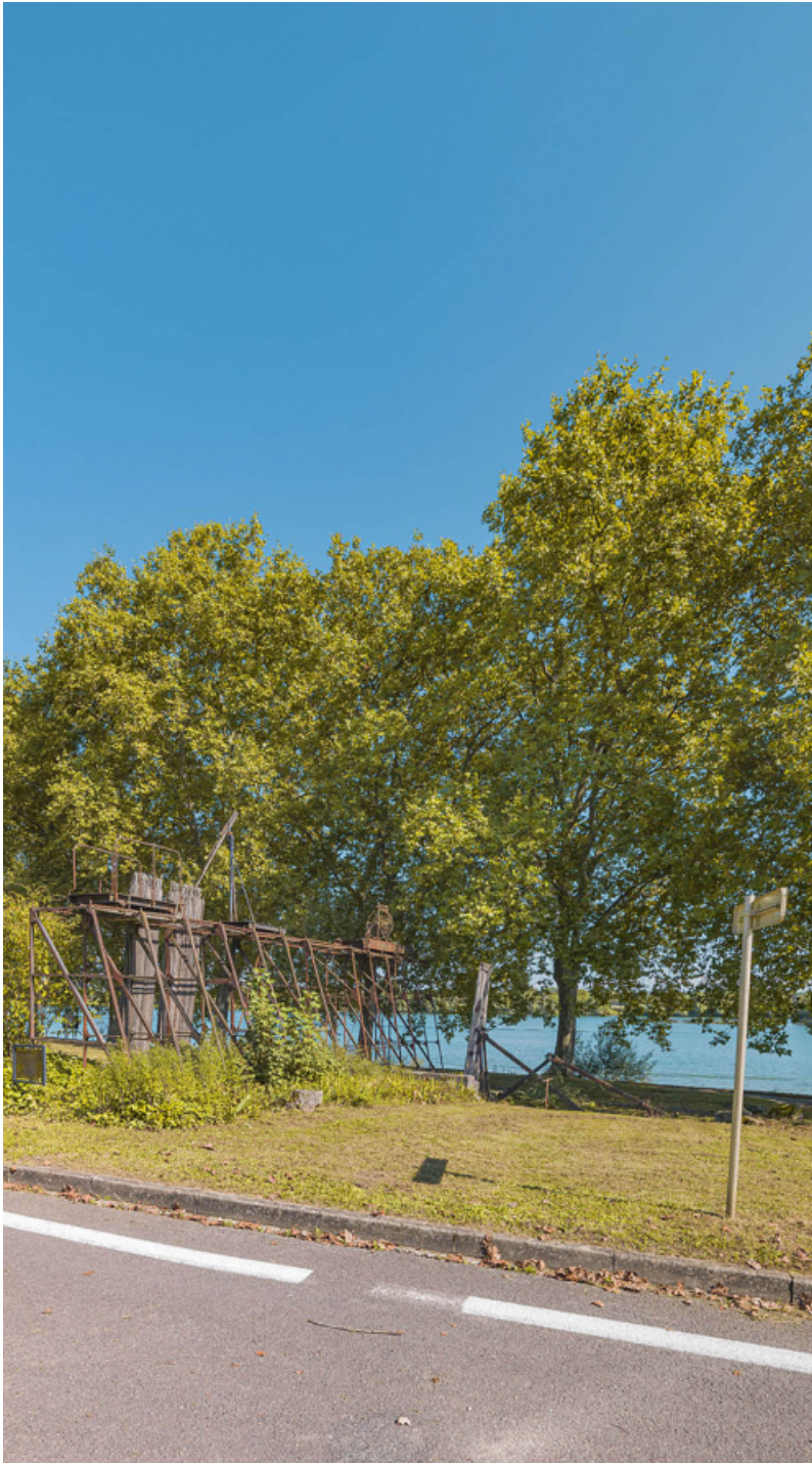
Les vestiges de l'ancien barrage de Thoissey à Mâcon.
