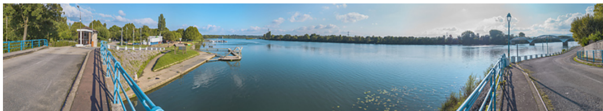
La Saône à la hauteur de Thoissey : à gauche, le barrage de Dracé et à droite, le pont de Thoissey.
