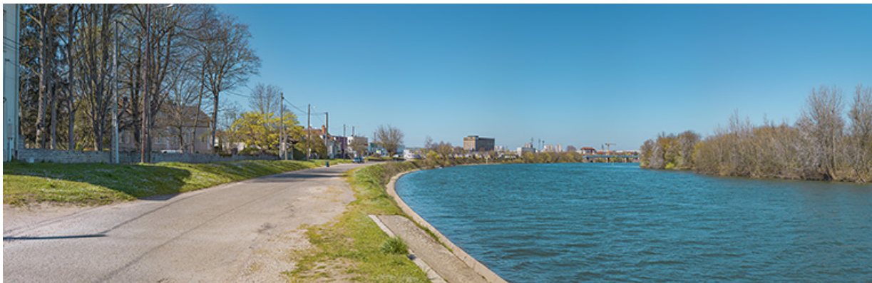
Les perrés du quai, avec en arrière-plan, le viaduc des Dombes. 71, Saint-Rémy quai Bellevue
