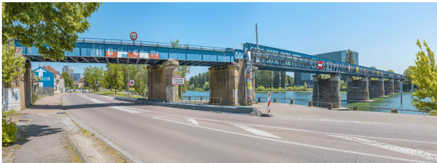
Le viaduc des Dombes : vu d'aval, rive droite.
