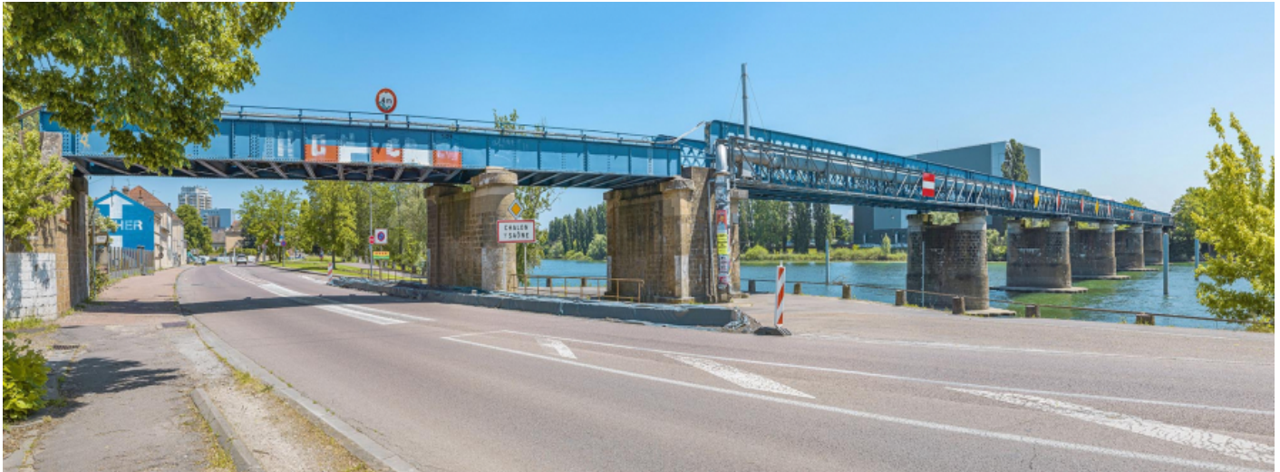
Le viaduc des Dombes : vu d'aval, rive droite. 71, Chalon-sur-Saône, lieudit : PK 140,6
