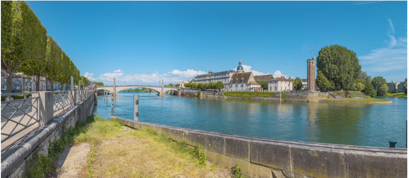
Vue d'ensemble du quai depuis la rive droite. Au premier plan, la rampe du quai des Messageries. 71, Chalon-sur-Saône, lieudit : Ile île Saint-Laurent
