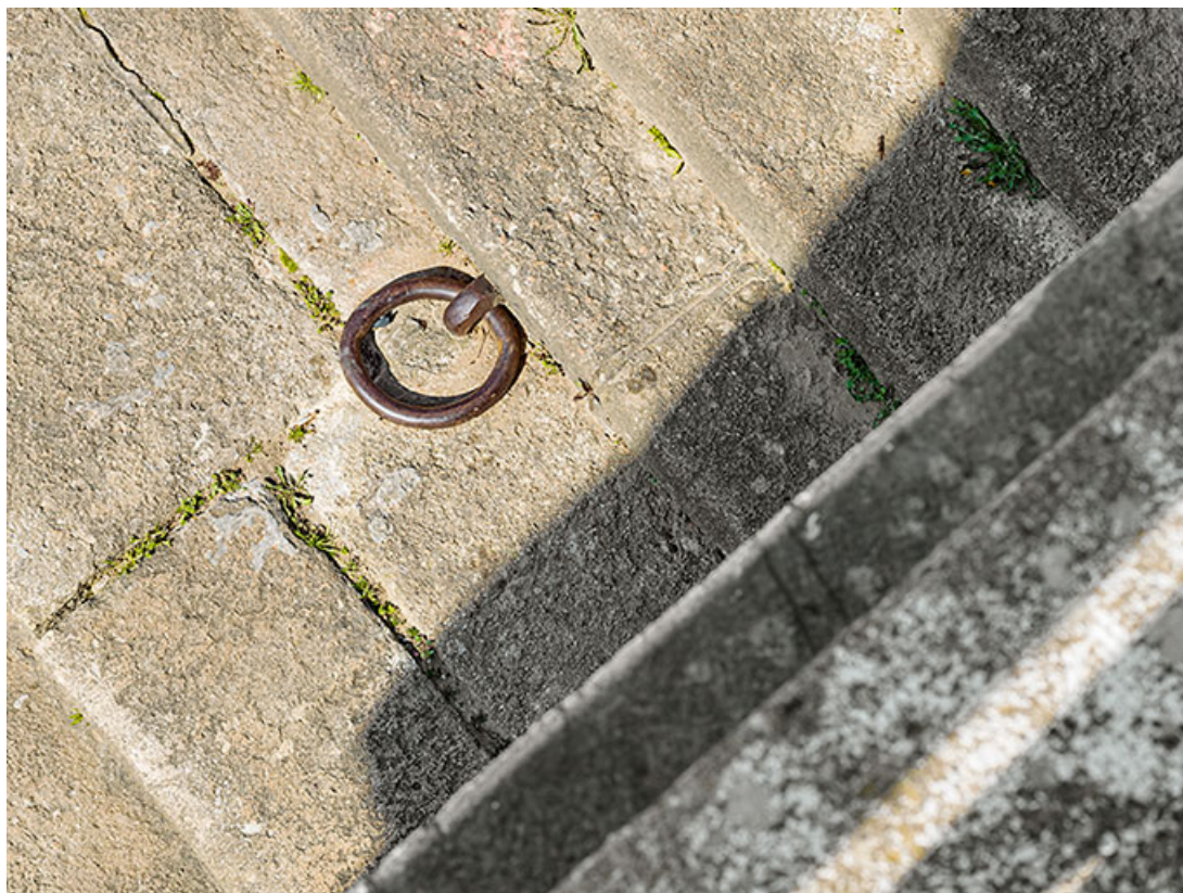
Détail d'un organeau sur les marches du port Villiers. 71, Chalon-sur-Saône
