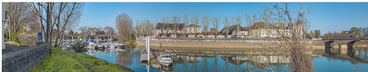
Vue d'ensemble du port de plaisance et des quais de l'île Saint-Laurent. A droite, le pont de la Génise. 71, Chalon-sur-Saône avenue de Verdun
