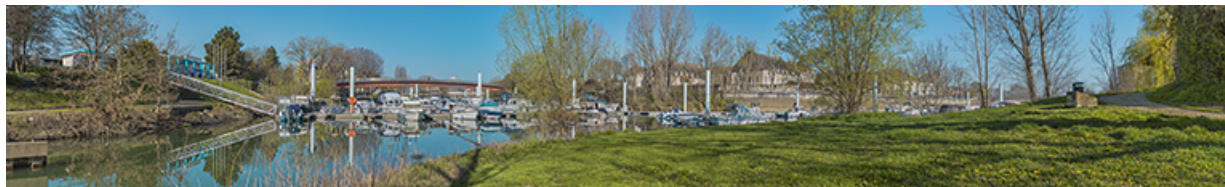
Vue d'ensemble du port de plaisance et de la passerelle.
