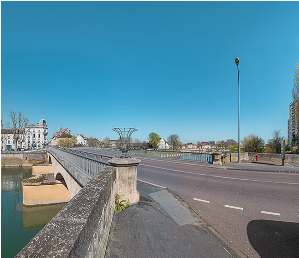
Vue d'ensemble du pont depuis la chaussée. 71, Chalon-sur-Saône rue de Strasbourg
