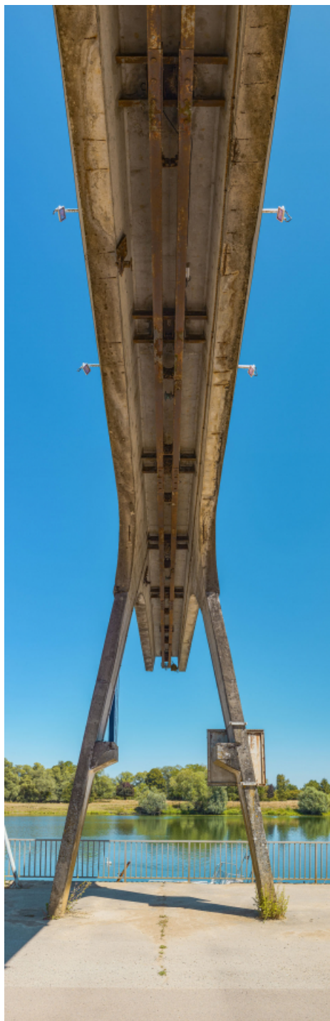
Portique de déchargement avec poulie.
