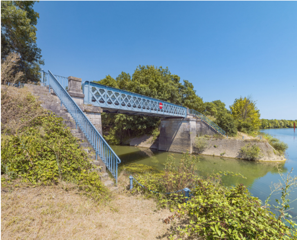
Vue d'ensemble du pont sur la Dheune.
