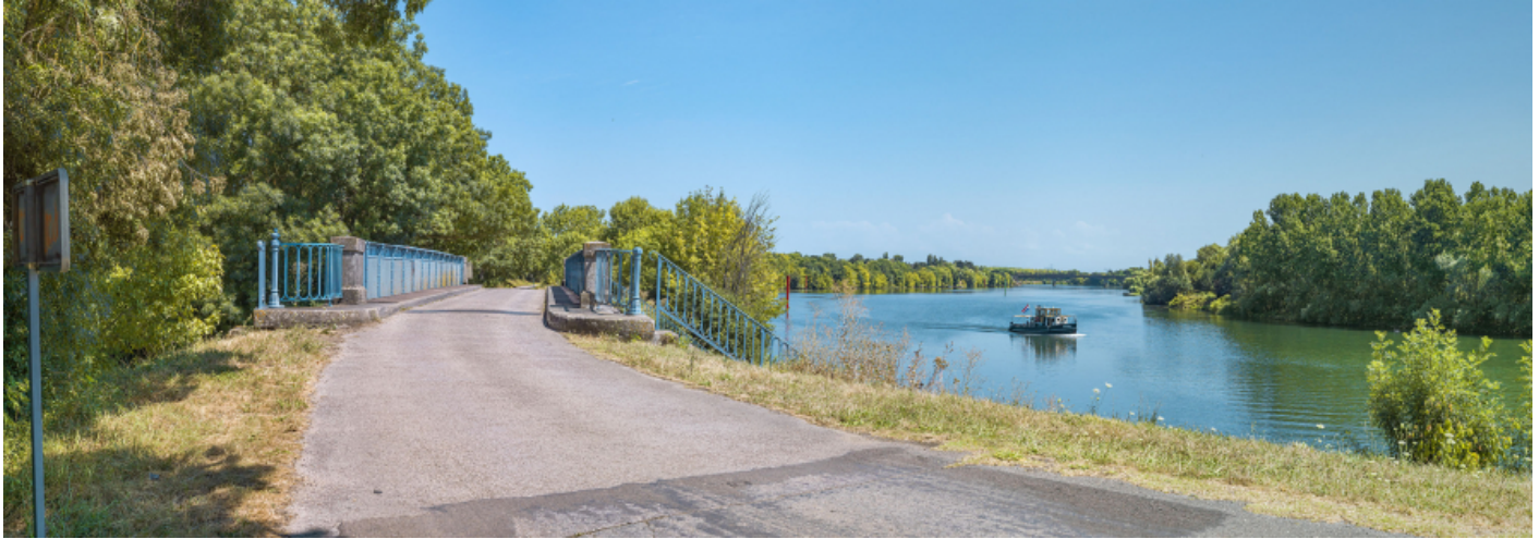
Le pont sur la Dheune, vu d'aval. En arrière-plan, on distingue le pont de Bragny.
