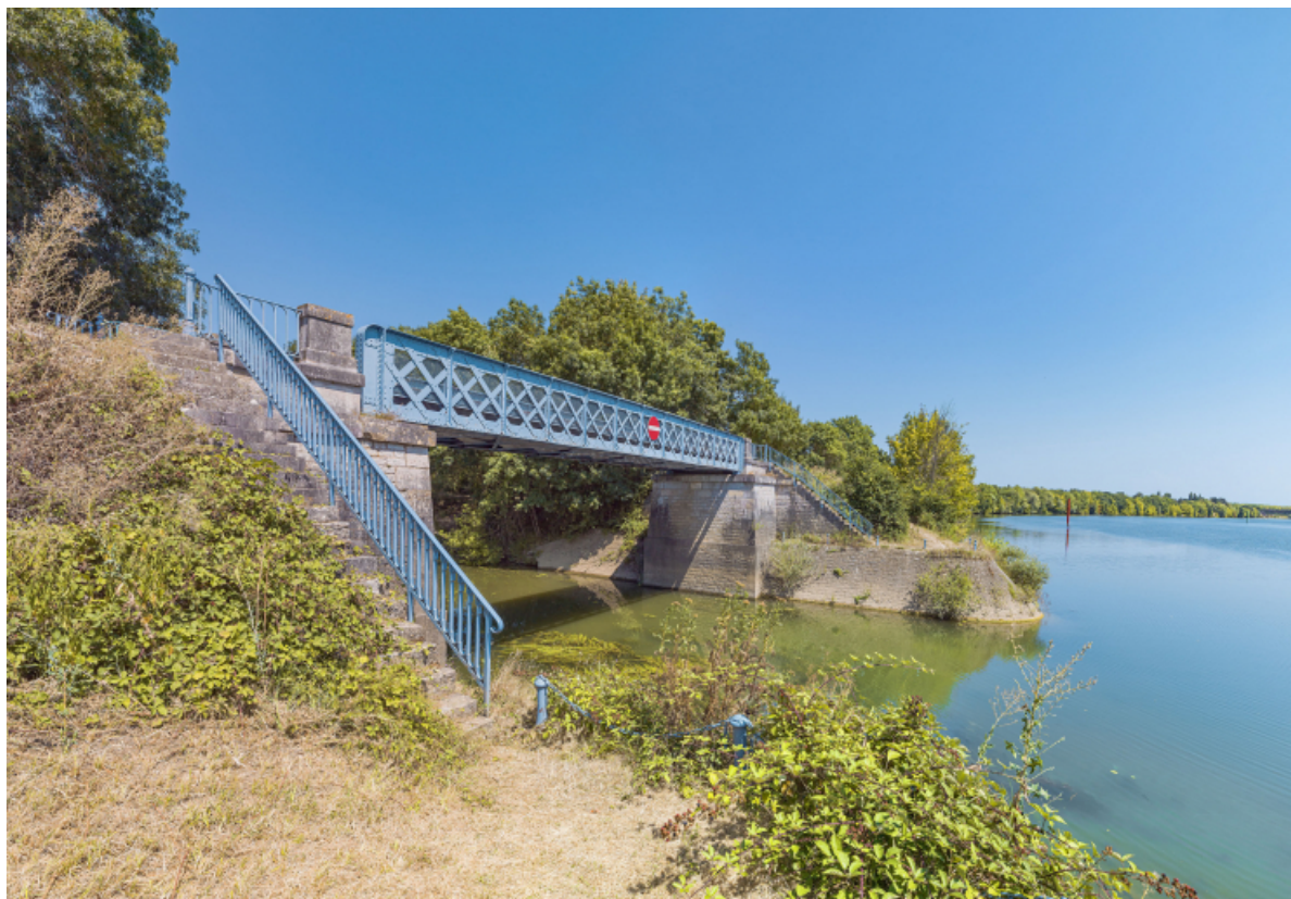
Vue d'ensemble du pont sur la Dheune.
