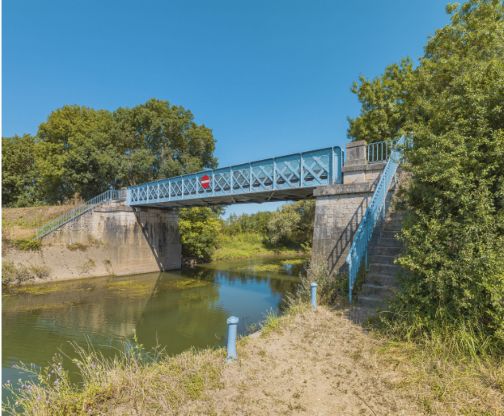
Le pont sur la Dheune, vu d'amont.
