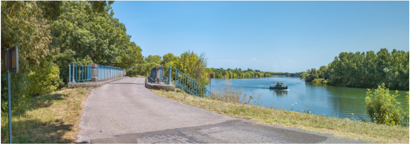
Le pont sur la Dheune, vu d'aval. En arrière-plan, on distingue le pont de Bragny.
