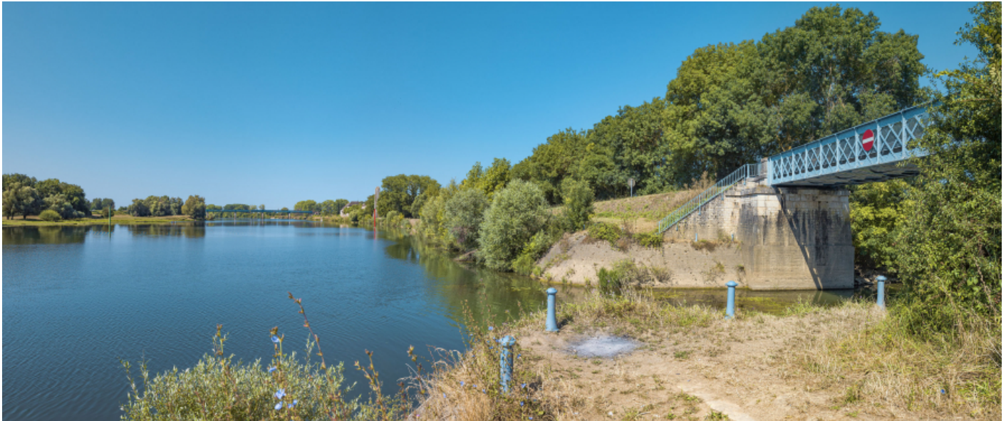
Le pont sur la Dheune, vu d'amont. En arrière-plan, la digue et le viaduc de Chauvort. 71, Bragny-sur-Saône, lieudit : PK 165,3
