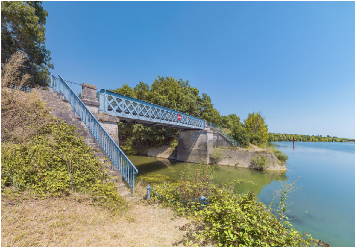
Vue d'ensemble du pont sur la Dheune.
