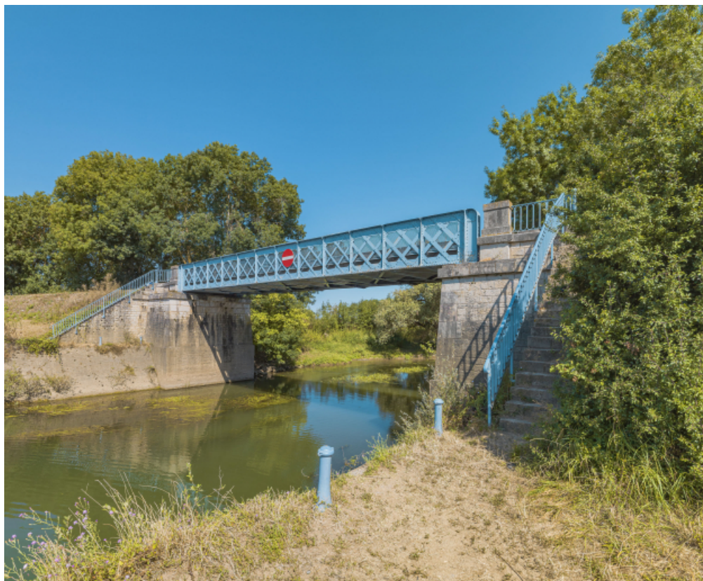
Le pont sur la Dheune, vu d'amont.
