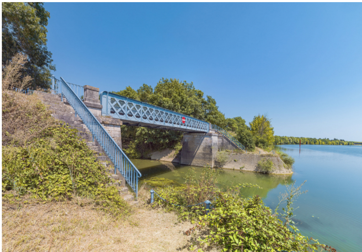
Vue d'ensemble du pont sur la Dheune.
