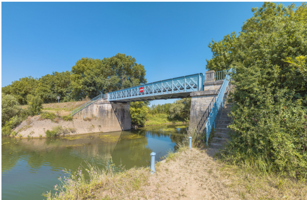
Le pont sur la Dheune, vu d'amont.
