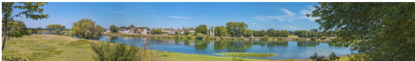
Vue d'ensemble du hameau de Chauvort et de la digue entre le pont sur la Dheune, en amont et le viaduc de Chauvort, en aval. 71, Allerey-sur-Saône, lieudit : Chauvort
