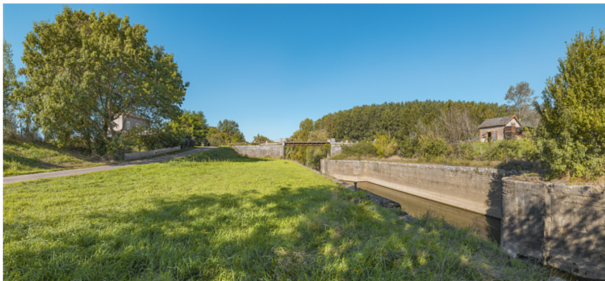
Vue d'ensemble du site de l'écluse de Charnay : à gauche, la maison éclésièrre, au centre, le pont sur écluse et à droite, la remise. 71, Charnay-lès-Chalon, lieudit : PK 176
