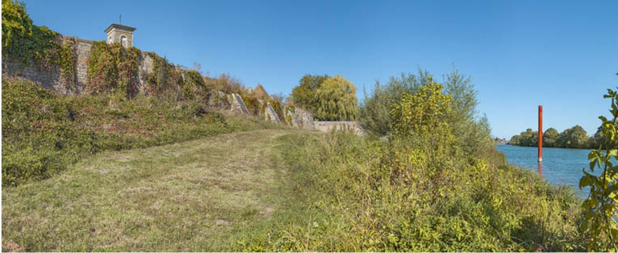
Les imposants murs en pierre, avec contreforts, au niveau du port et de l'église d'Écuellen.
