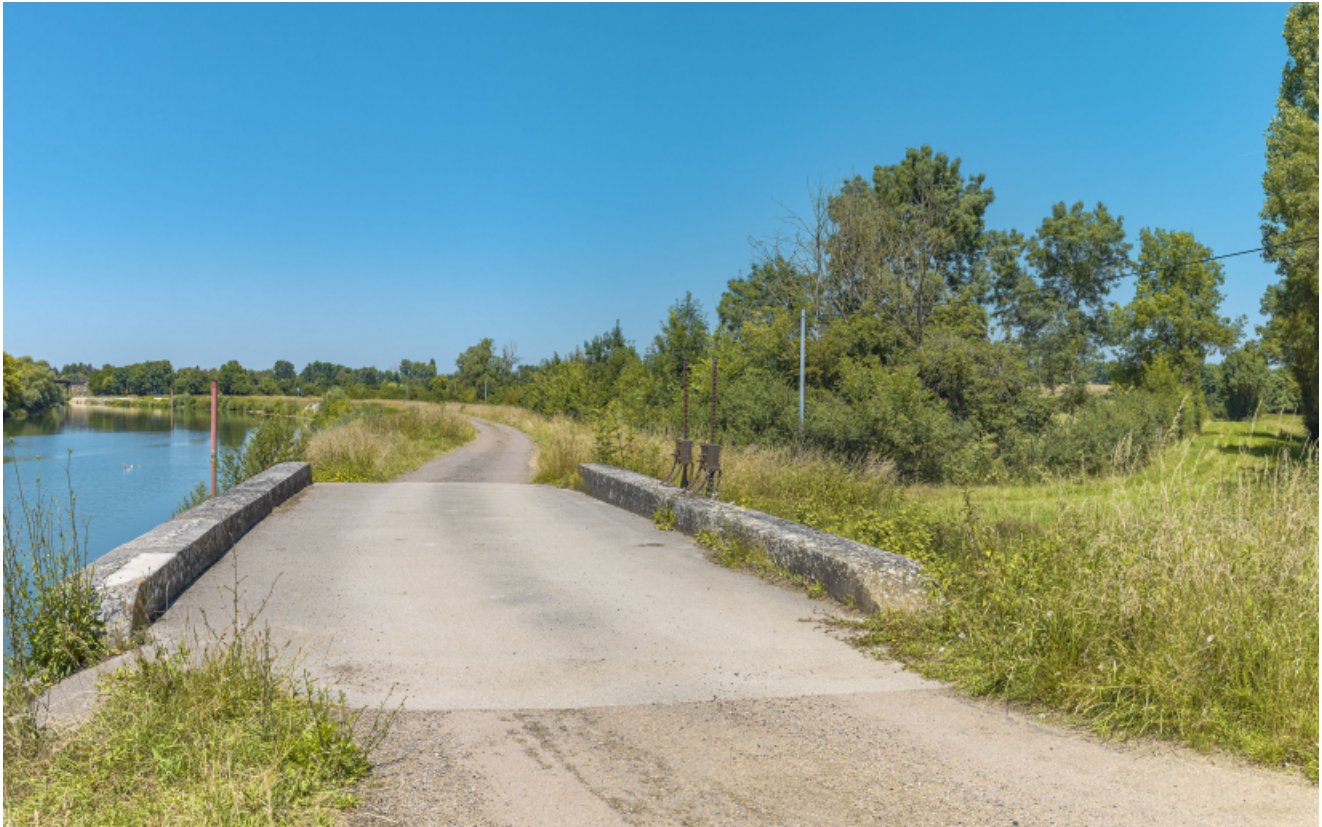
Ponceau vu du dessus : passage du chemin de halage. Les parapets en pierre de taille sont bien visibles.
