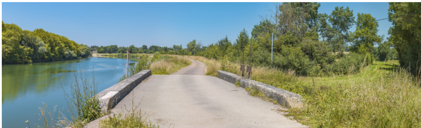
Ponceau vu du dessus : passage du chemin de halage. Les parapets en pierre de taille sont bien visibles.
