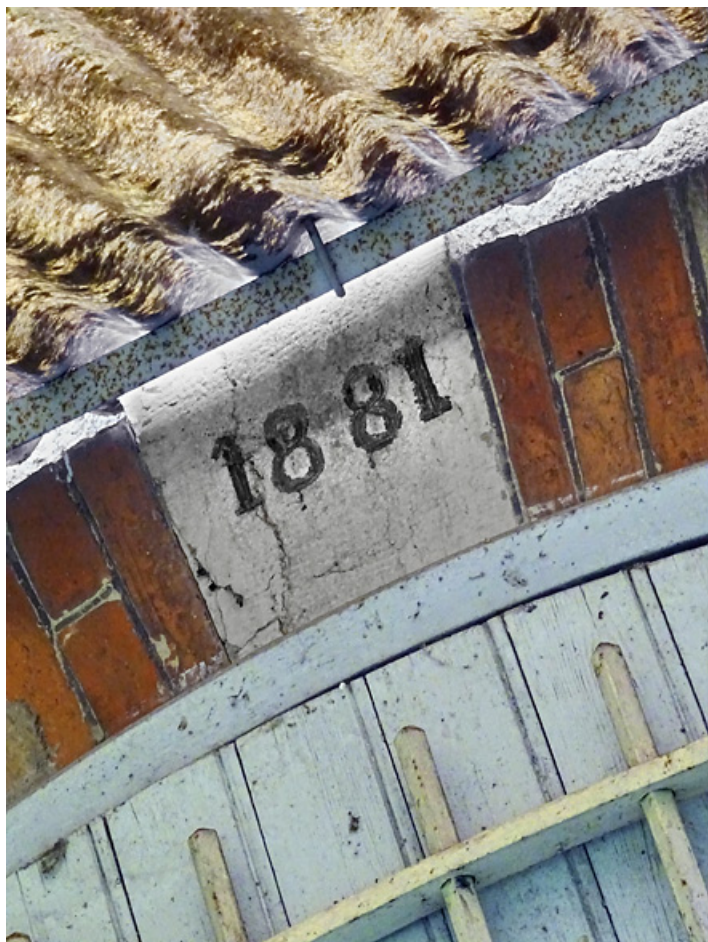
Détail du linteau de la porte d'entrée avec la date de construction de la maison.
