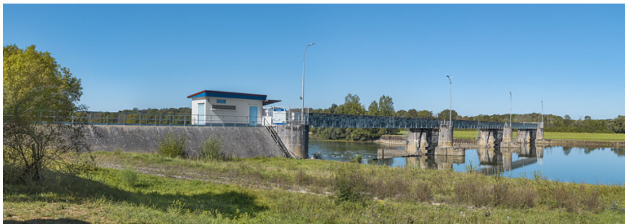
Vue d'ensemble d'amont depuis Charnay-lès-Chalon, rive gauche.
