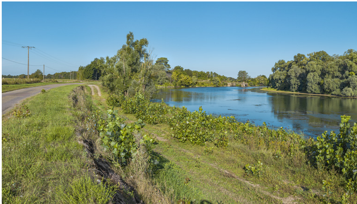
Partie de bief en amont de l'ancien barrage, au niveau de l'entrée dans la dérivation de Charnay.
