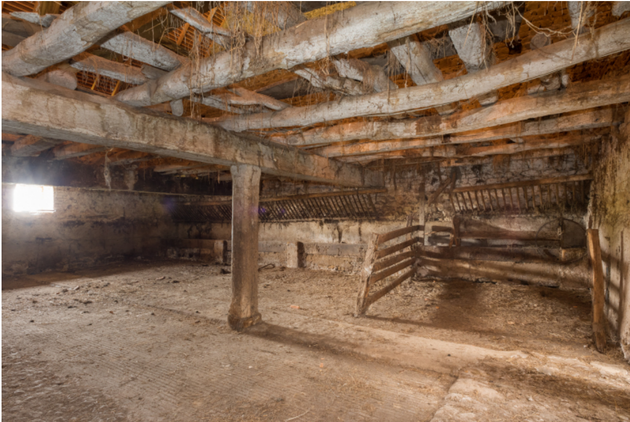
Vue de l'étable double, à gauche de la remise 71, Oyé, lieudit : Chaumont
