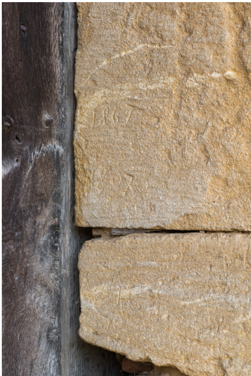
Pierre dans l'encadrement de la porte charretière de la remise portant des inscriptions gravées, notamment deux dates (1807 et 1867) dont la signification n'est pas connue.
