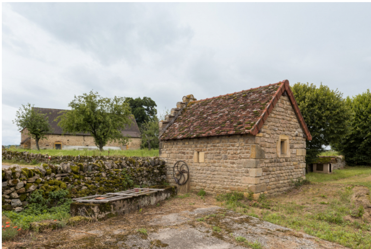
Vue du bâtiment de pompage, d'où provenait l'eau destinée à remplir l'abreuvoir (ou bachasse).
