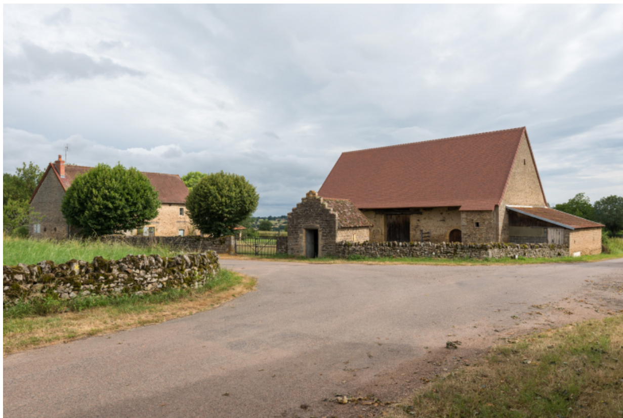
Vue d'ensemble d'une des fermes qui dépendaient du château, face à l'entrée de celui-ci 71, Oyé, lieudit : Chaumont
