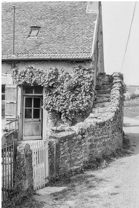
Détail de la même ferme : vue de l'escalier extérieur, construit contre le mur-pignon et donnant accès aux combles de la maison. 71, Changy, lieudit : Tourny
