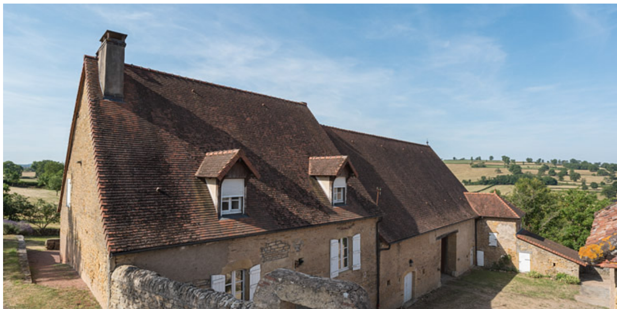
Ferme du XVIIIe siècle, propriété d'un riche laboureur, devenu emboucheur à la fin de ce siècle.
