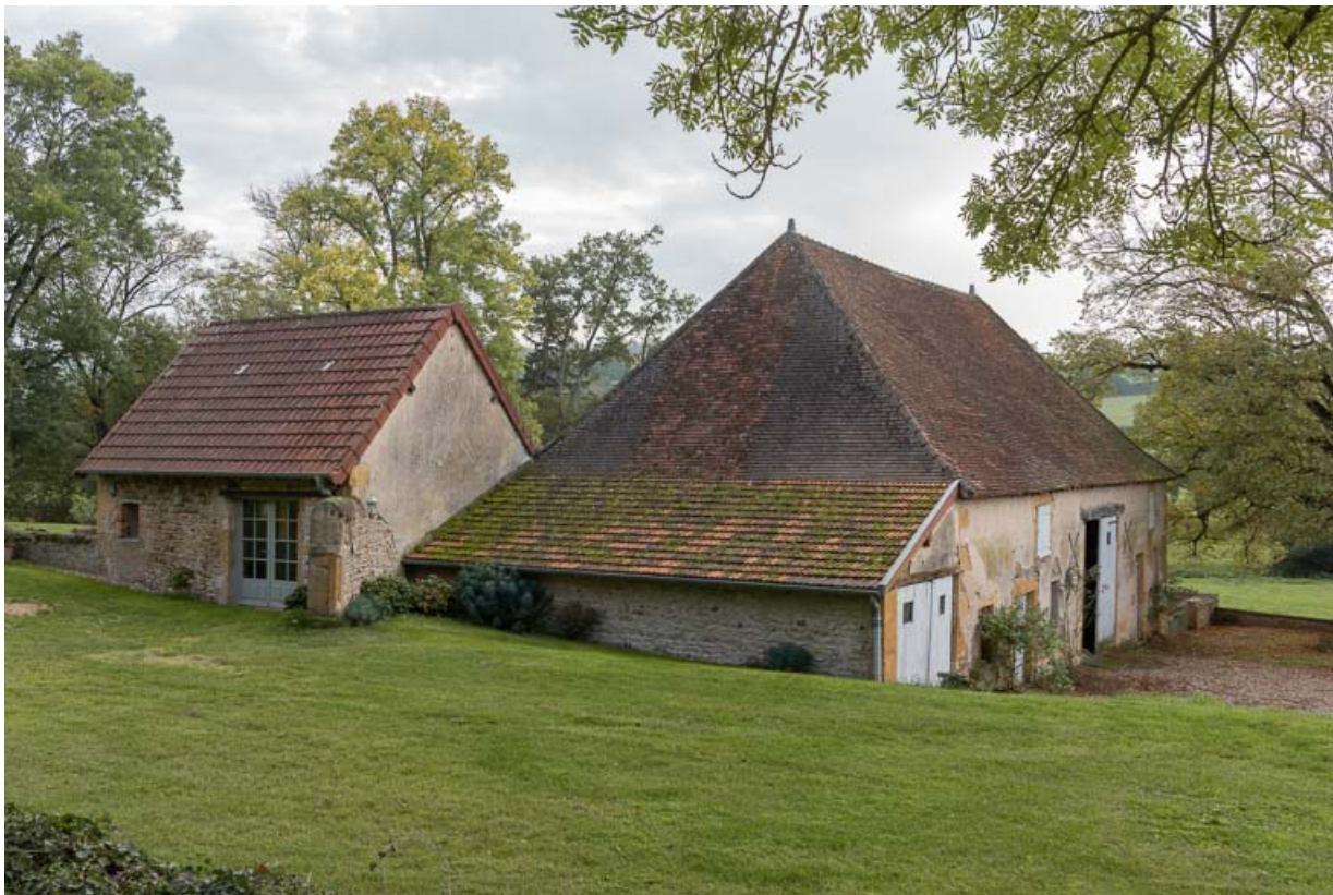
Vue des dépendances, construites dans la seconde moitié du XIXe siècle : le chenil et la grange.
