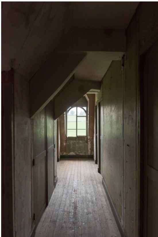
Corridor dans le comble, desservant les anciennes chambres de domestiques 71, Sarry, lieudit : Essiat
