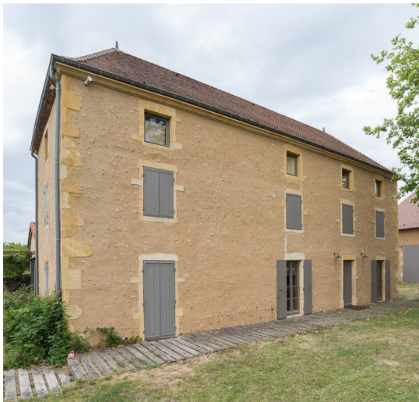
Façade antérieure de la maison de la ferme du Bois-Dieu
