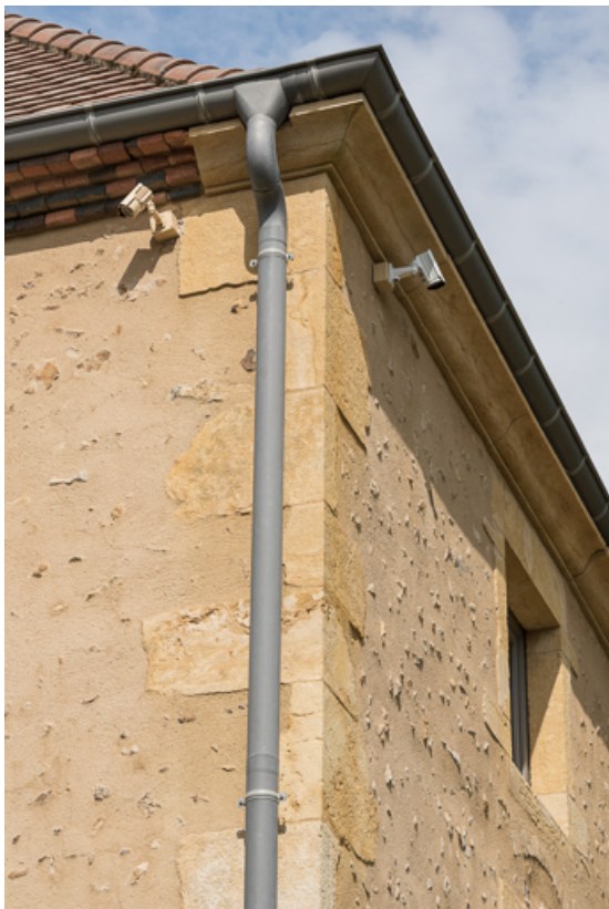
Détail de la corniche en pierre calcaire sur la façade antérieure de la maison 71, Varenne-l'Arconce, lieudit : les Mauduits
