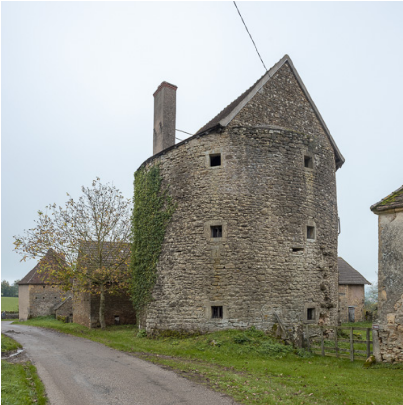
Vue de la tour de Chassagne et des bâtiments de ferme environnants au nord-ouest, depuis la voie communale n°3 71, Ouroux-sous-le-Bois-Sainte-Marie, 1541 route de Chassagne, lieudit : Grand Champ de Chassagne Chassagne
