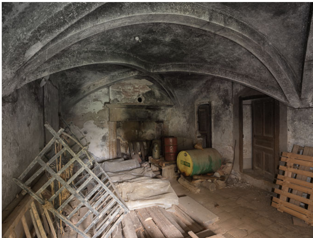
Pièce principale voûtée (ancienne cuisine ?) du rez-de-chaussée de la tour
