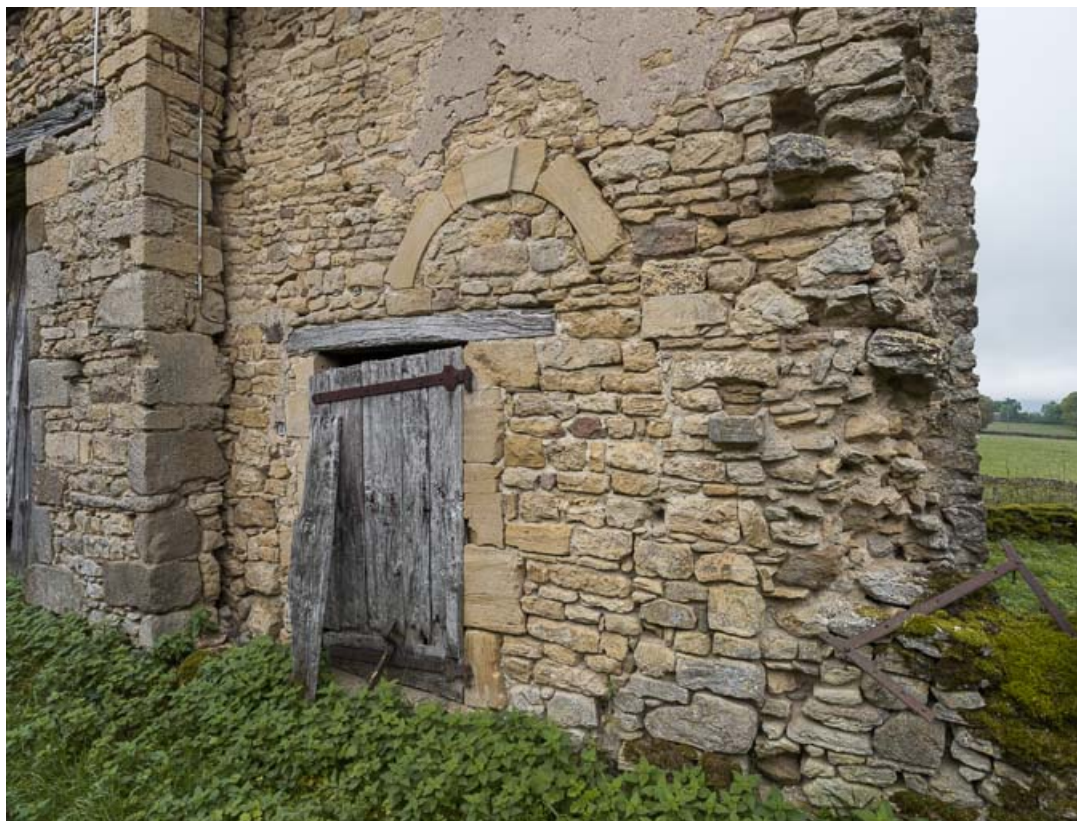
Extrémité de la grange, à l'est de la cour. La maçonnerie conserve l'arc en plein cintre (avec agrafe) qui couvrait l'ancienne porte de la chapelle et les traces d'arrachements d'un mur qui devait clotûrer la cour intérieure du château.
