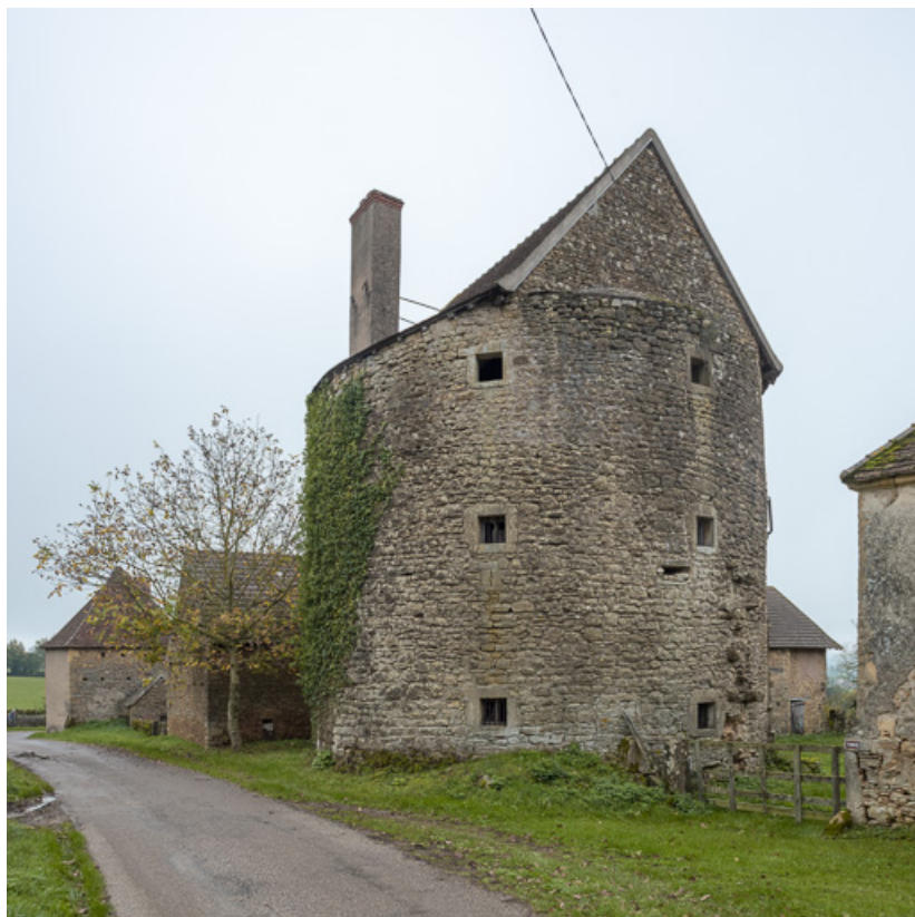
Vue de la tour de Chassagne et des bâtiments de ferme environnants au nord-ouest, depuis la voie communale n°3 71, Ouroux-sous-le-Bois-Sainte-Marie, 1541 route de Chassagne, lieudit : Grand Champ de Chassagne Chassagne
