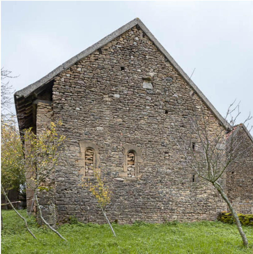
Mur-pignon sud de la grange. Deux anciennes baies cintrées, aujourd'hui bouchées, éclairaient à l'origine l'intérieur de la chapelle. 71, Ouroux-sous-le-Bois-Sainte-Marie, 1541 route de Chassagne, lieudit : Grand Champ de Chassagne Chassagne
