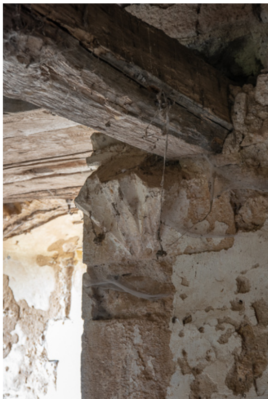
Culot marquant le départ de la voûte d'ogives qui couvrait à l'origine le second étage de la tour
