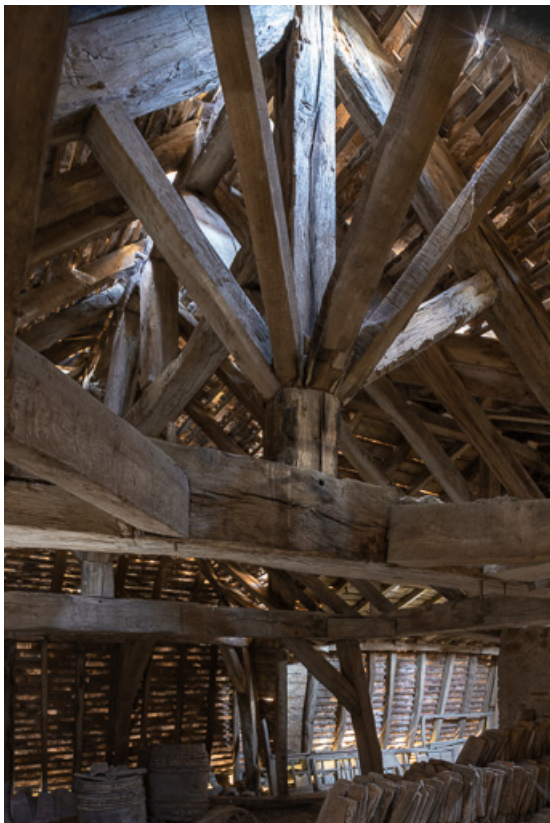
Détail de la charpente : poinçon et contrefiches
