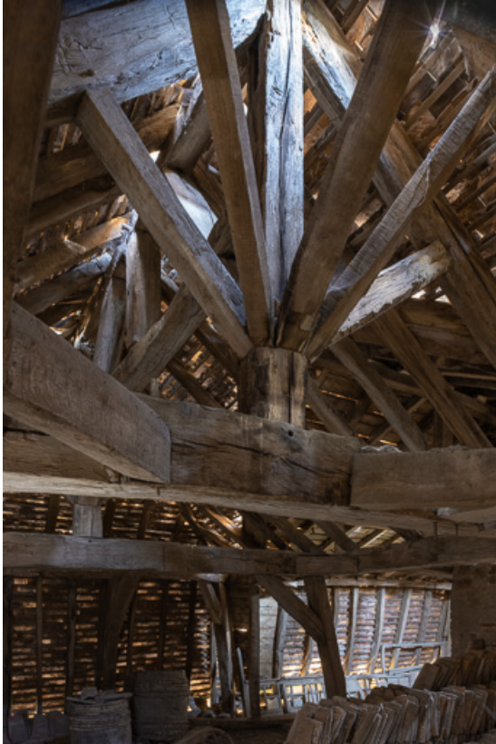
Détail de la charpente : poinçon et contrefiches
