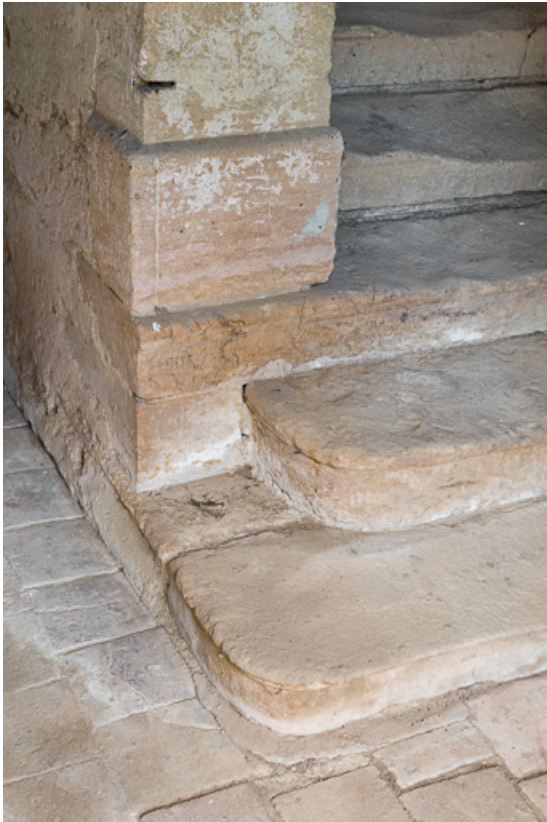
Moulure, à la base du mur-noyau de l'escalier
