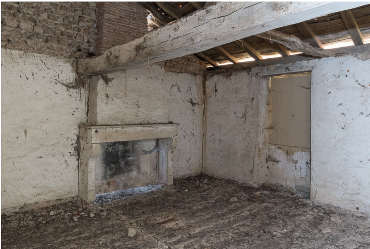
Chambre à l'étage, dans l'ancienne maison. Un plancher sépare la pièce des combles, au niveau où s'arrête l'enduit à la chaux, de couleur blanche, couvrant les murs.
