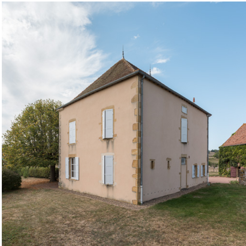
Vue de la façade postérieure de la demeure et de sa façade latérale est 71, Saint-Julien-de-Jonzy, lieudit : Parigny
