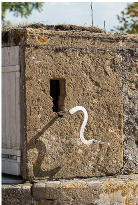
Détail du puits : superstructure avec la date "1822" gravée en partie haute 71, Saint-Julien-de-Jonzy, lieudit : Parigny
