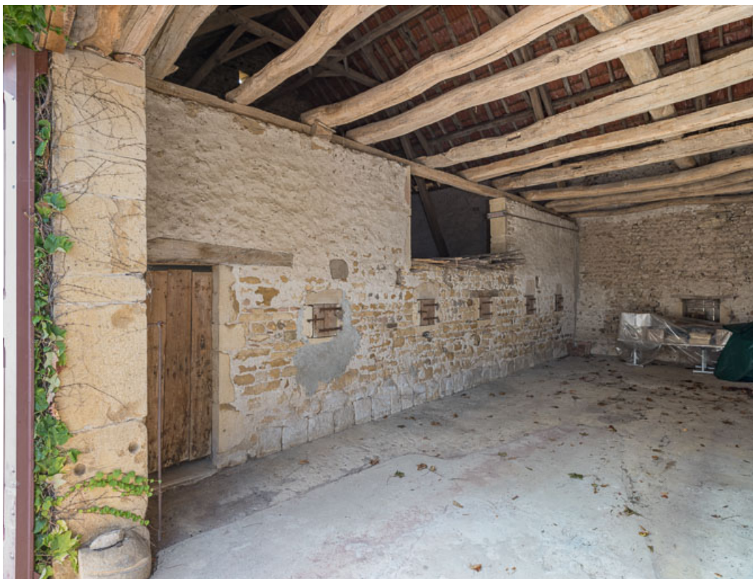
Vue intérieure de la grange. Le mur entre la remise et l'étable est percé de feurons.
