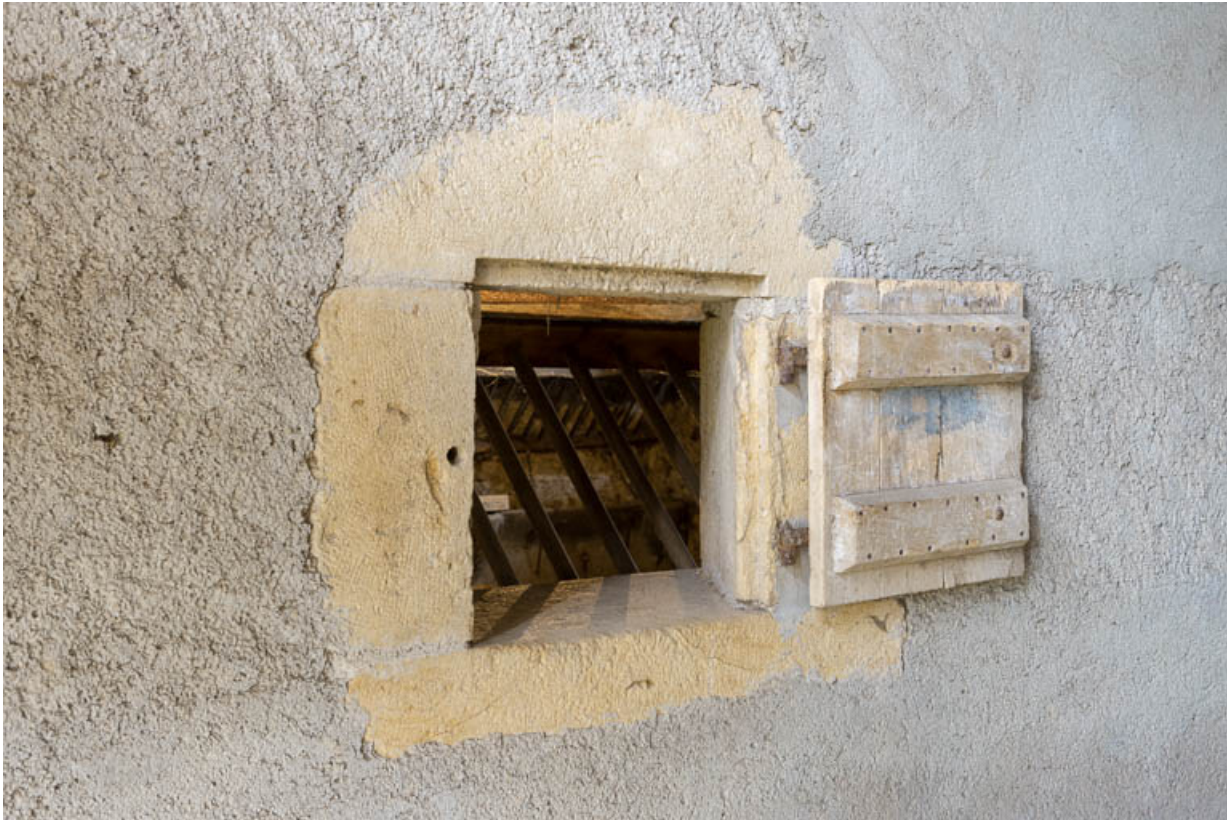
Feuron permettant de disposer le foin dans les rateliers depuis l'espace de la remise, où est placé le char.
