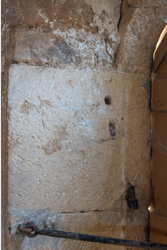
Embrasement de la porte de l'étable à gauche de la remise. L'emplacement des gonds de la porte d'origine est encore visible. 71, Briant, lieudit : Farges
