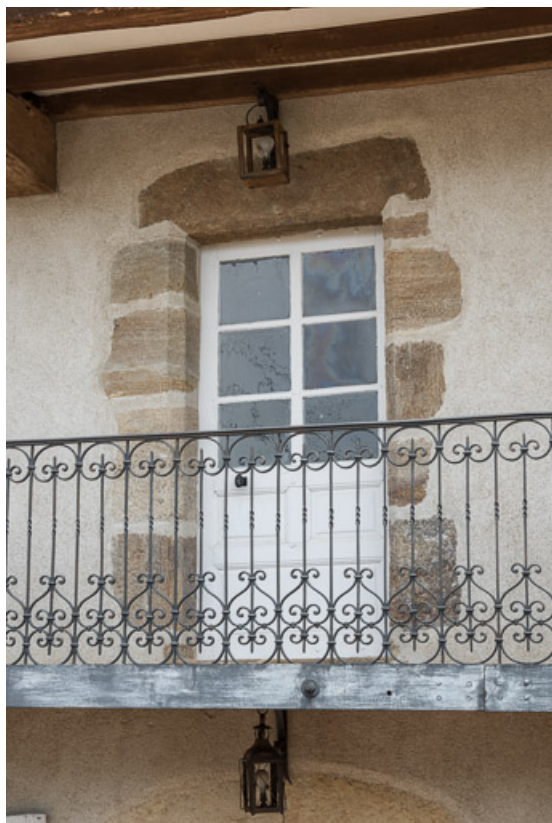
Porte chanfreinée (XVIIe s.) donnant accès à la galerie à l'étage
