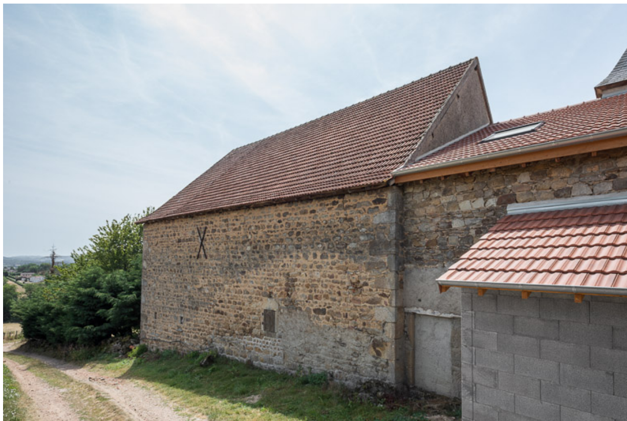
Façade postérieure de la grange. A l'emplacement du petit appentis en parpeings, se trouvait le four à pain. 71, Saint-Symphorien-des-Bois, lieudit : Giverdier
