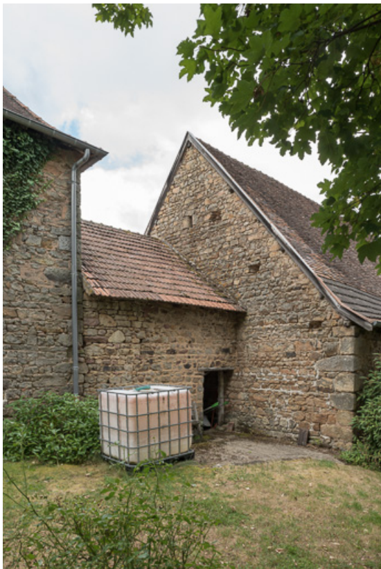
Façade postérieure de cette même remise.
