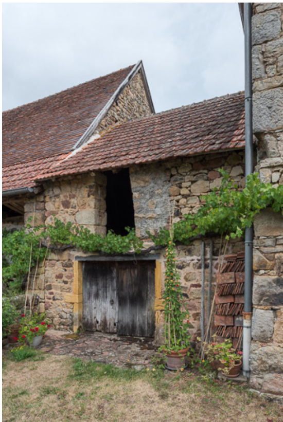
Façade antérieure de la remise, construite entre la maison et la grange primitive, après le partage de la propriété au milieu du XVIIIe siècle.
