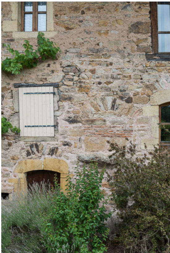
Détail de la façade antérieure de la maison. Au centre, l'évacuation de la pierre d'évier. 71, Colombier-en-Brionnais, 55 route de Frâgne, lieudit : Frâgne
