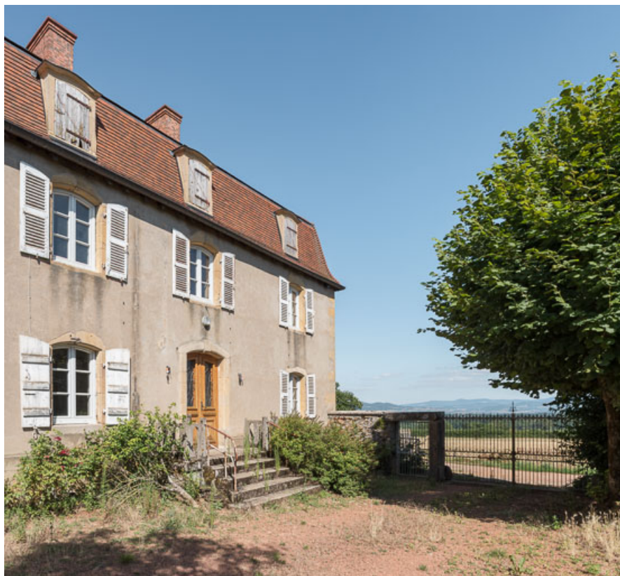
Vue d'une partie de la façade antérieure de la demeure à l'ouest
