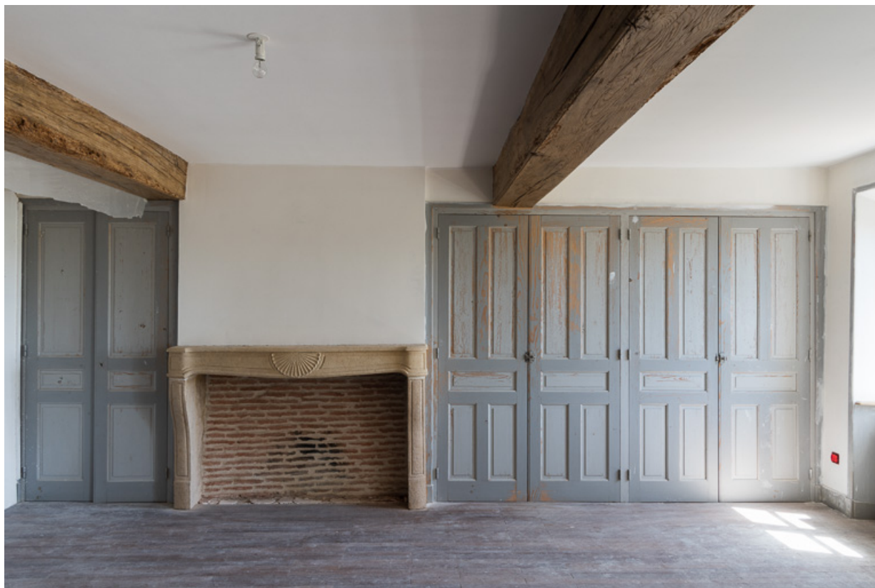
Une des chambres de l'étage avec sa cheminée (XVIII siècle) et une série de placards, aménagée au début du XXe siècle 71, Ligny-en-Brionnais, lieudit : les Sertines
