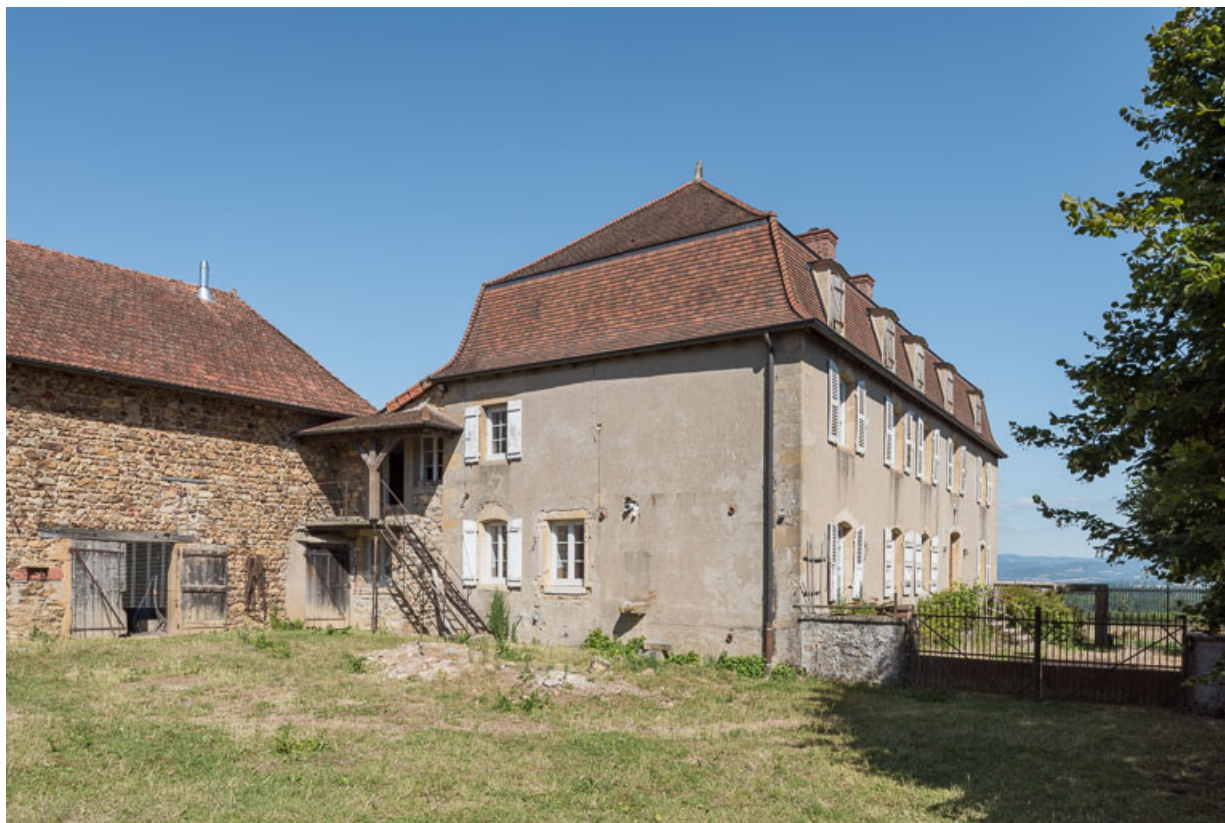
Vue de la demeure et d'une partie de la grange, depuis l'ouest. Les deux bâtiments sont partiellement accolés, au niveau de l'angle sud-est de la grange et de l'appentis, à l'arrière de la maison.
