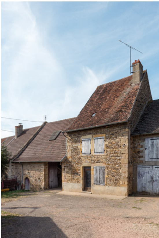
Vue de la ferme n°4 (A 379).
