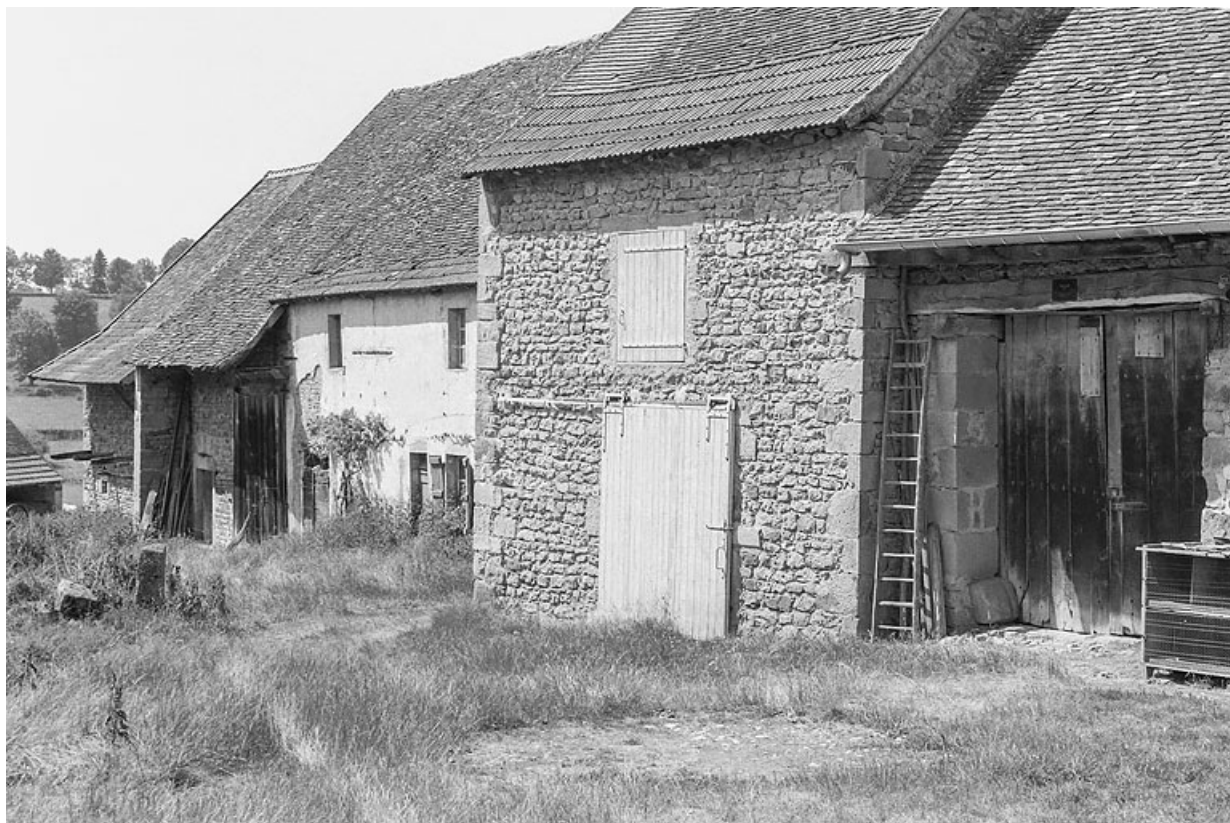
Vue des bâtiments, constituant la seconde partie de l'alignement, vers 1970.
