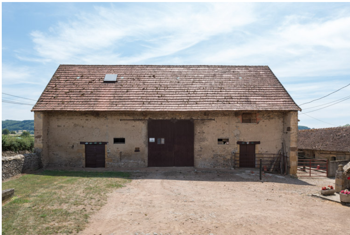
Grange, au sud de la cour
