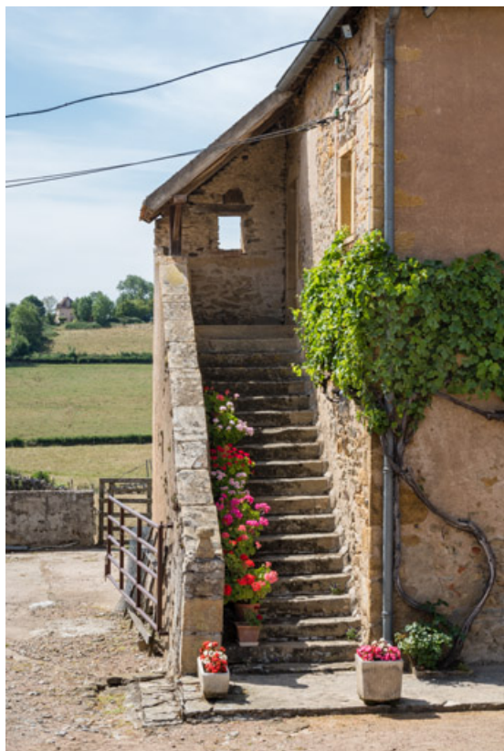
Escalier extérieur, sur la façade latérale de la maison, qui donnait accès à l'étage 71, Dyo, lieudit : Mans
