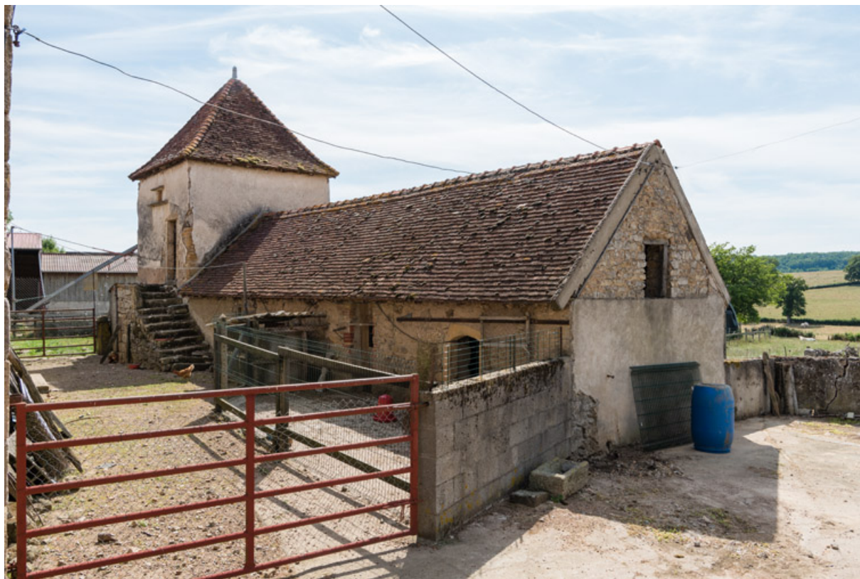
Bâtiment de dépendance composé d'un pigeonnier, d'un four à pain et de soues à cochons et poulailler 71, Dyo, lieudit : Mans
