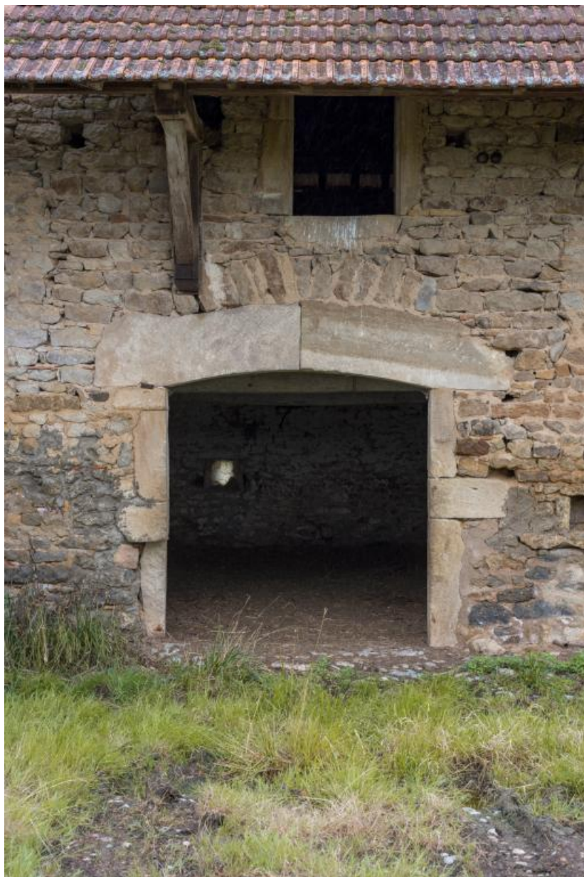
Détail de la grange : ouverture du fenil et porte d'étable
