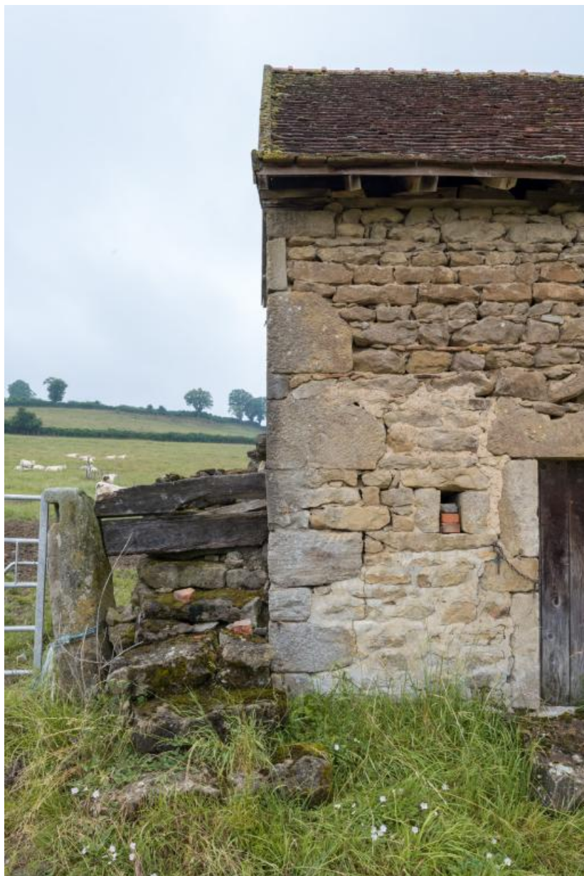
Détail de la dépendance secondaire : escalier permettant l'accès au grenier 71, Amanzé, lieudit : Grange Plassard
