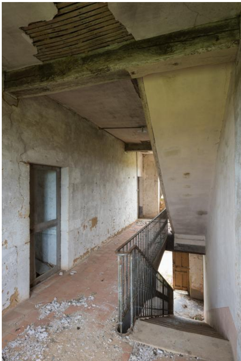
Escalier de la maison, à deux volées droites
