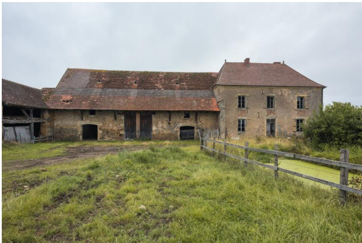
Façade antérieure des bâtiments principaux : grange et maison
