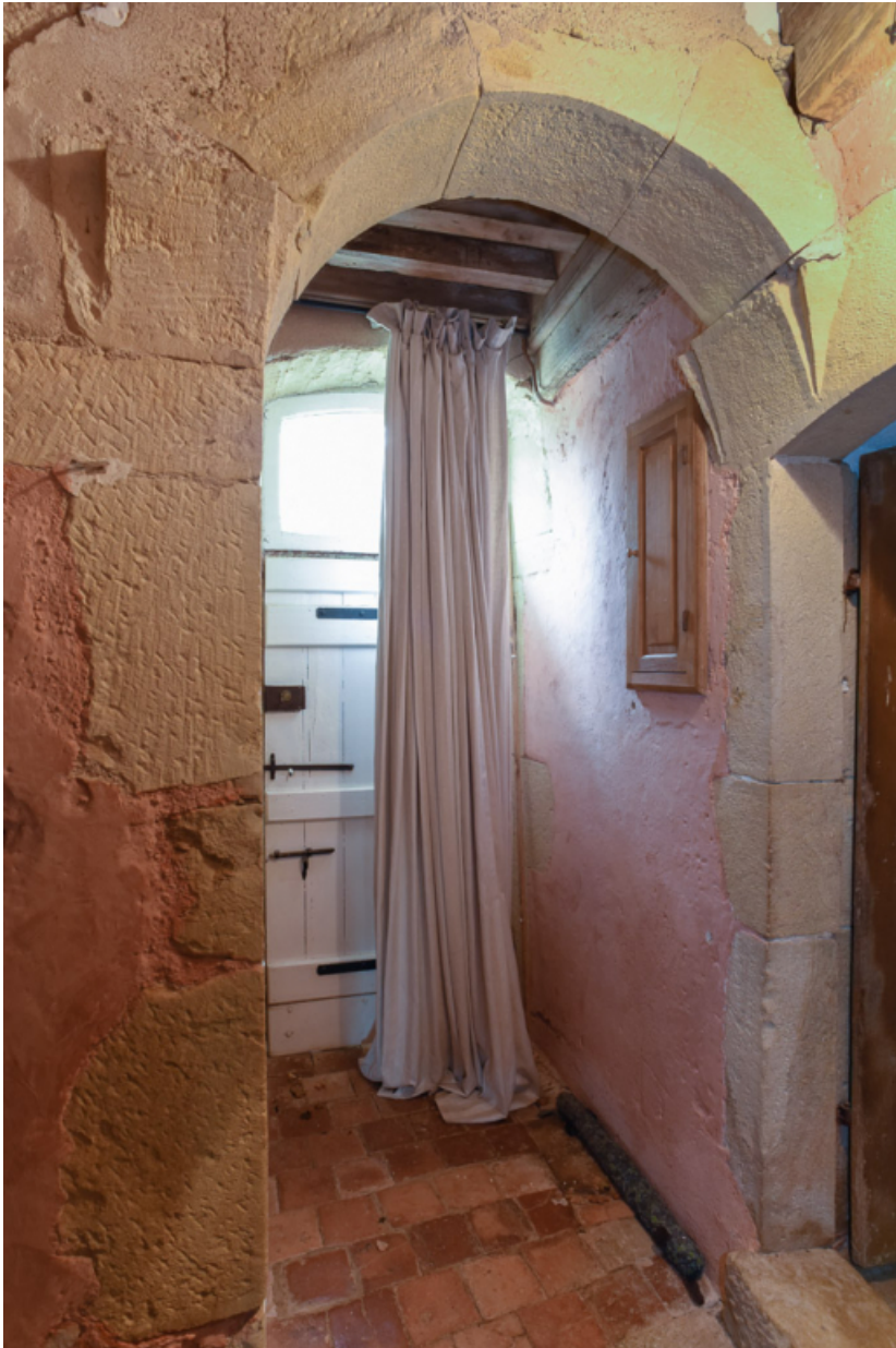
Petit vestibule, à l'entrée de la maison. Des pierres d'attentes montrent que des arcs étaient vraisemblablement prévus pour couvrir les ouvertures menant du vestibule vers les autres pièces..
