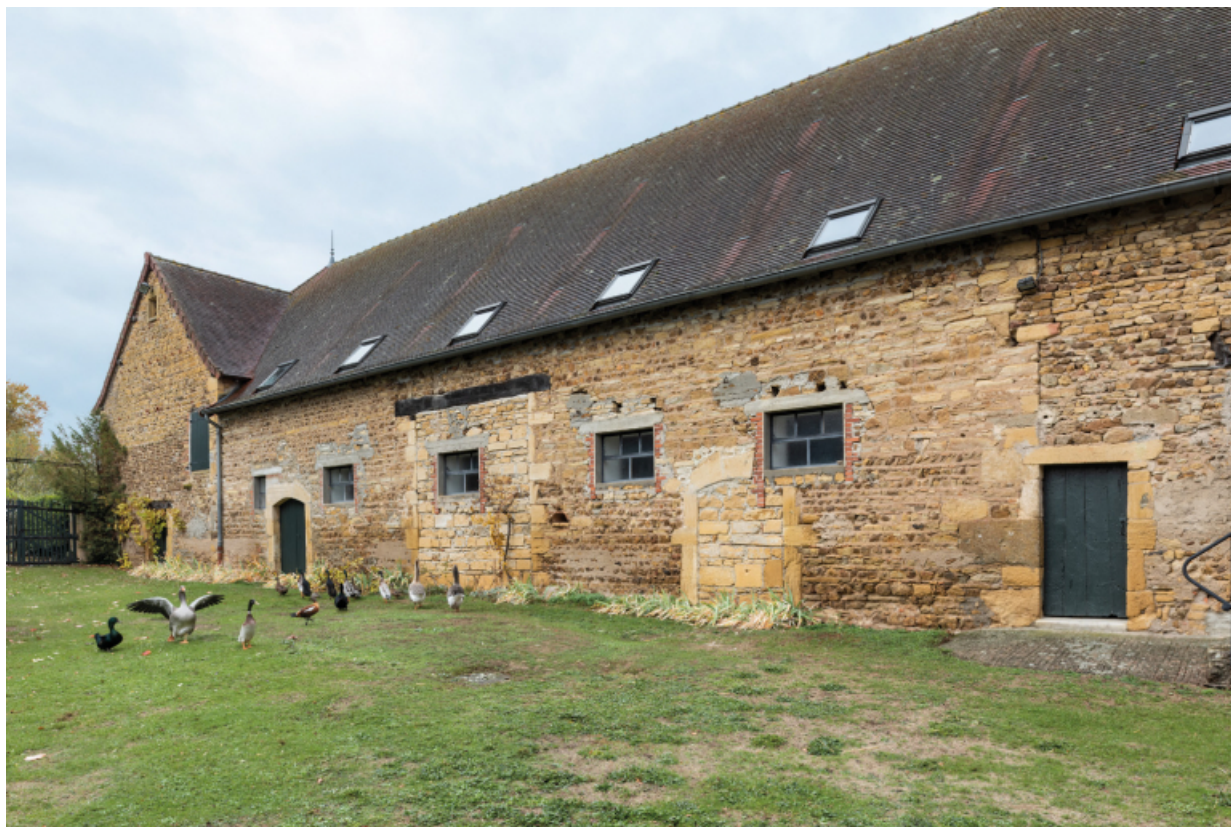
Façade antérieure de la grange, modifiée au XXe siècle
