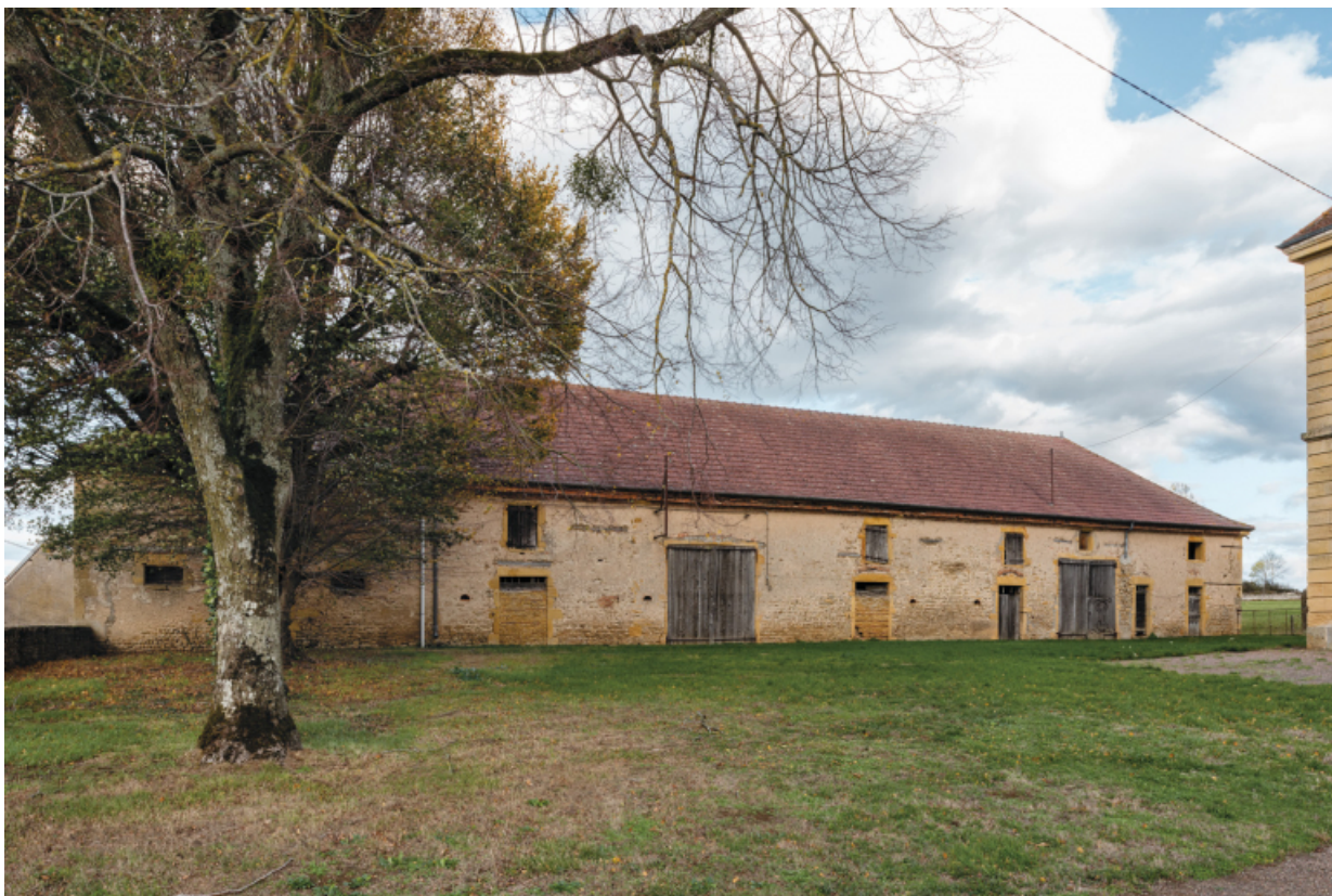
Façade sud-ouest de la grange, du côté du château
