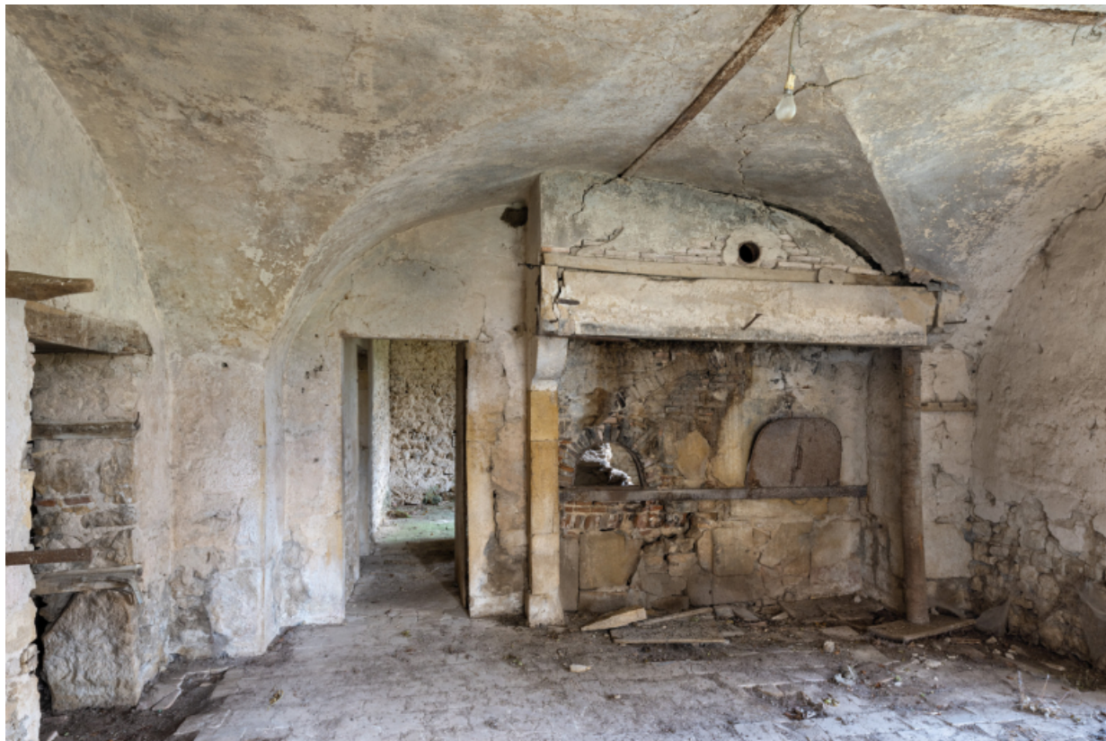
L'ancien fournil, à l'extrémité est de la grange
