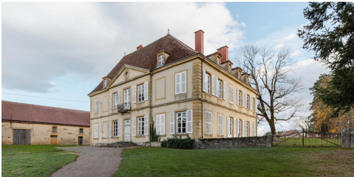
Vue d'ensemble avec la demeure et la grange, au fond de la cour
