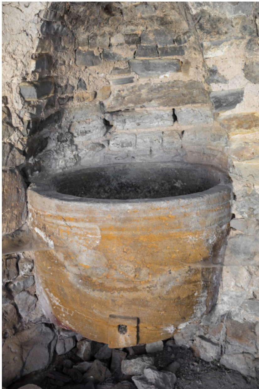
Vue rapprochée : cuve.
