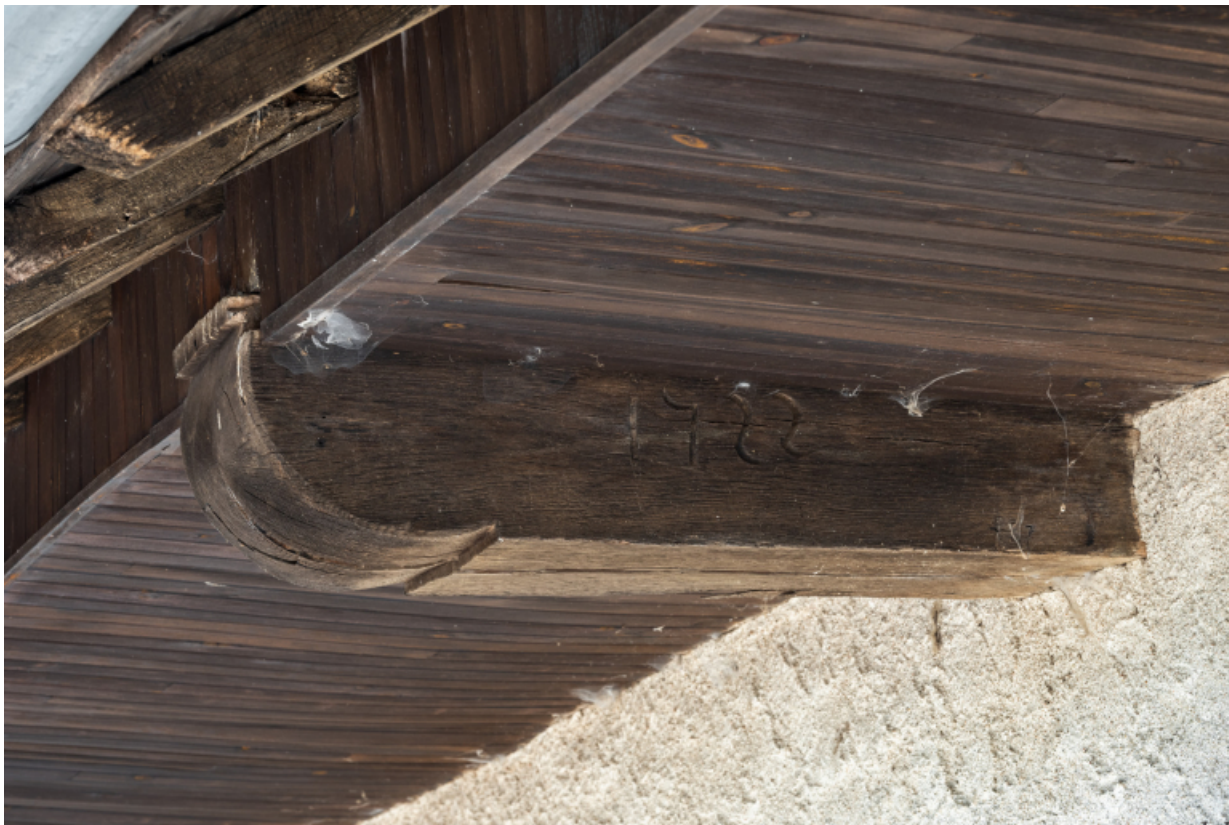
Vue de détail de la date 1722 sur un élément de charpente.
