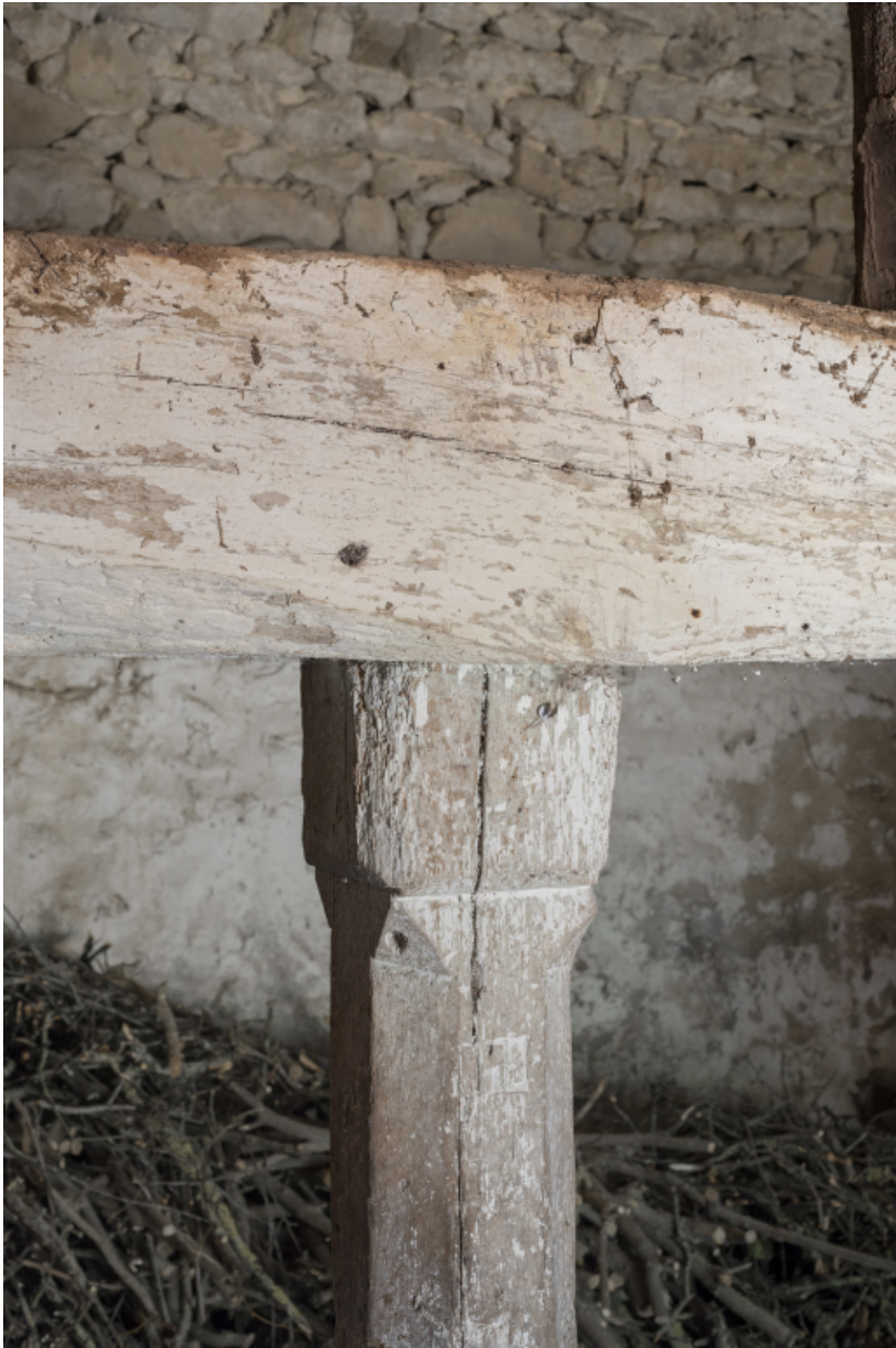
Vue rapprochée d'un assemblage poutre-poteau.
