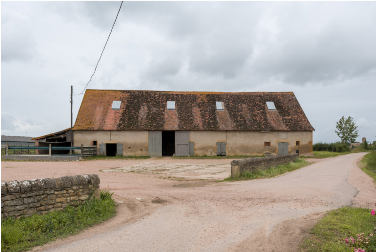
Façade antérieure du bâtiment agricole.
