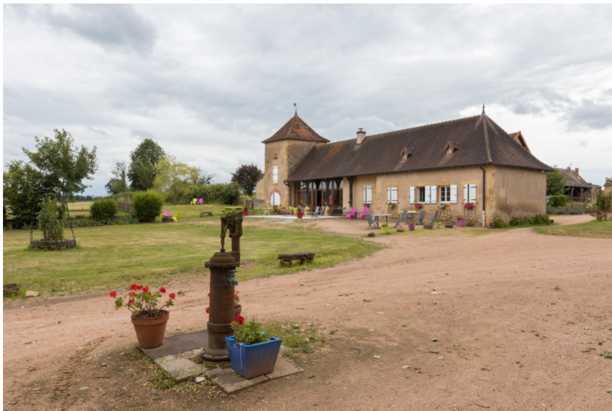
Remise et pigeonnier vus depuis le nord-est.
