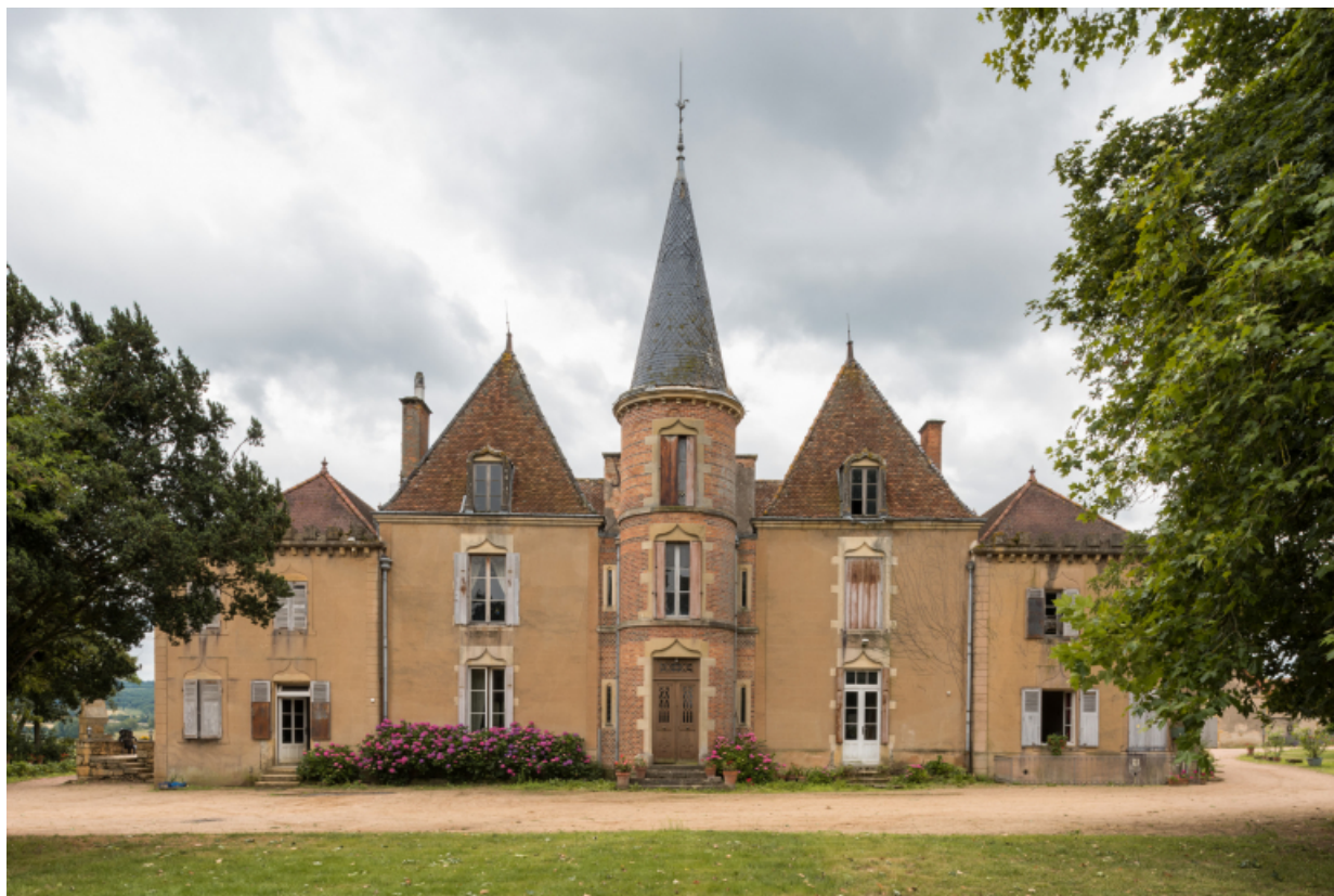
Façade postérieure de la demeure.
