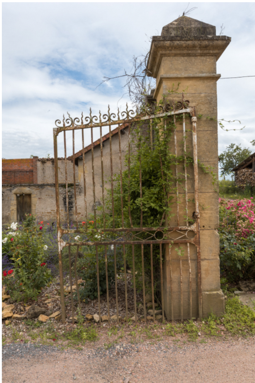
Détail du portail d'entrée de la demeure.
