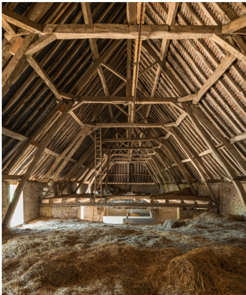
Charpente du bâtiment agricole. Vue depuis le fenil (cadrage vertical).
