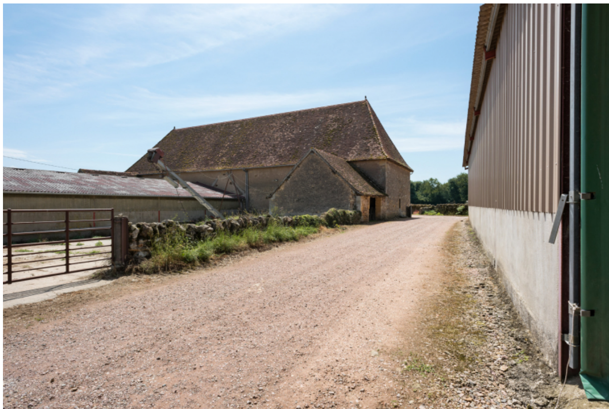
Bâtiment agricole vu de trois quarts arrière.
