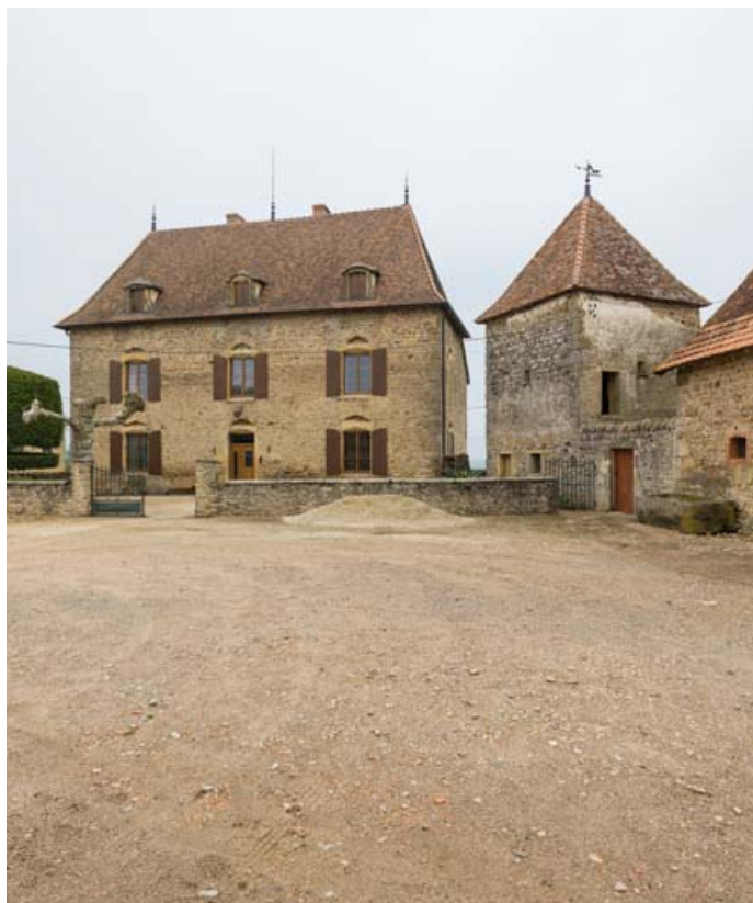
La maison et le pigeonnier, depuis le sud-est.
