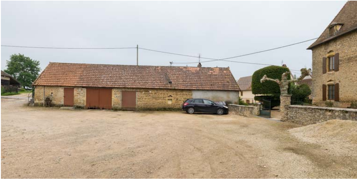
Bâtiment agricole : écurie, remise et bûcher. 71, Saint-Julien-de-Civry, lieudit : La Noue
