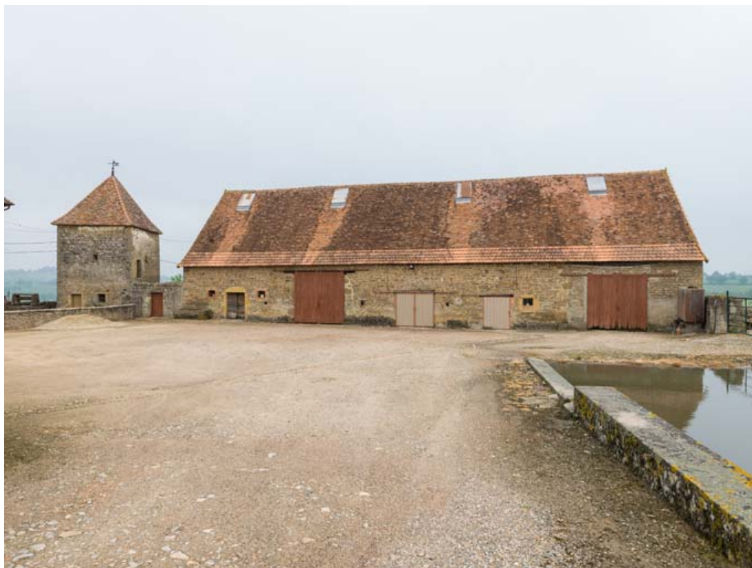
Vue d'ensemble depuis l'entrée : le colombier et l'étable.
