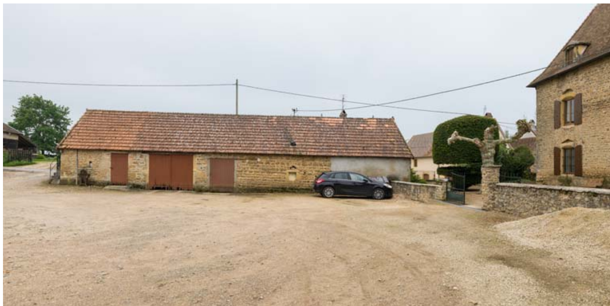
Bâtiment agricole : écurie, remise et bûcher.
