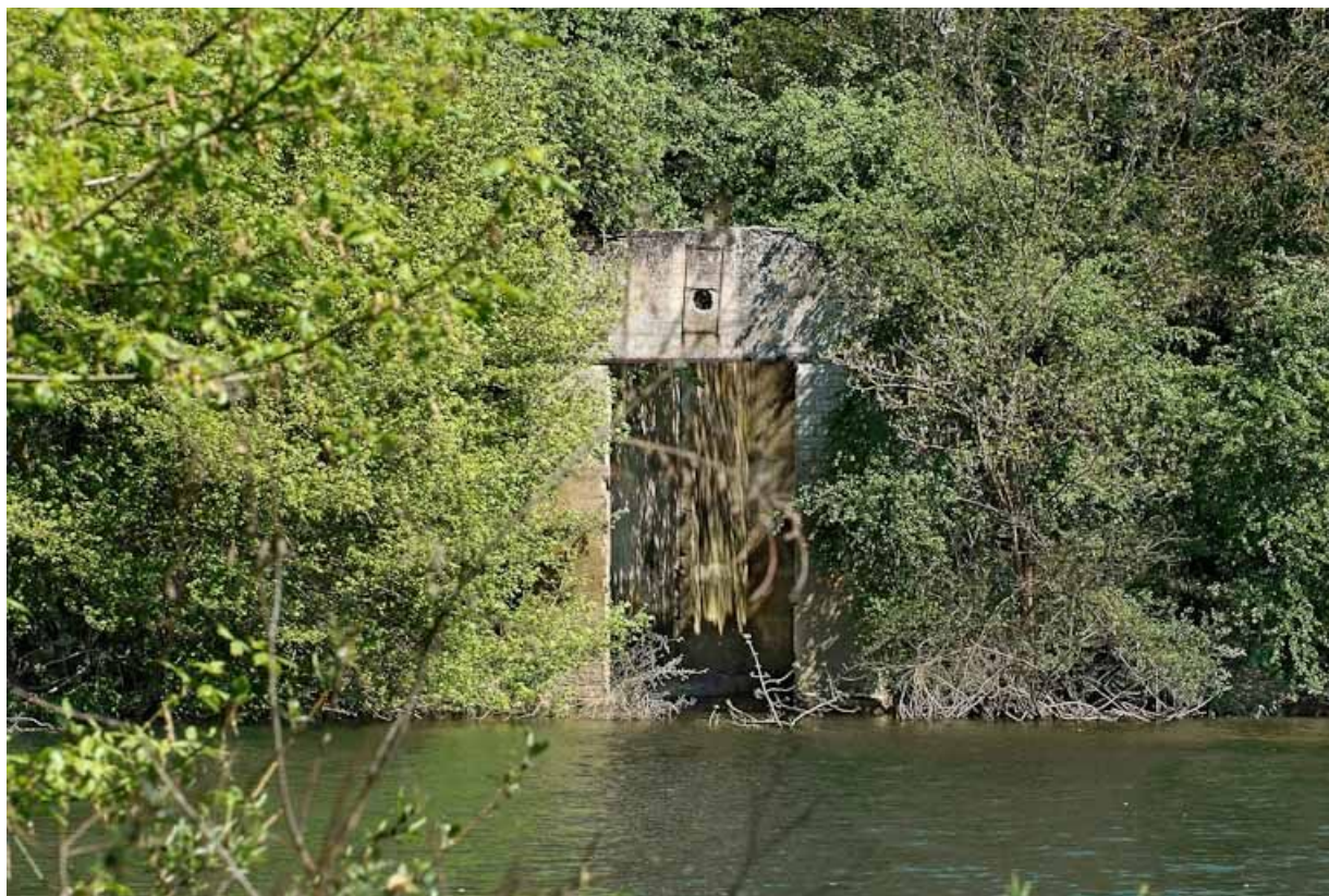
Un garage à bateau (?) sur la rive gauche de la Seille, en bas du parc du château de Saint-Romain.
