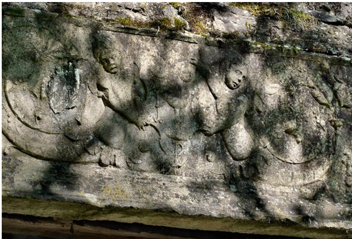
Ruines de l'église Saint-Maurice. Détail du très beau linteau 16e siècle avec putti et arabesques.
