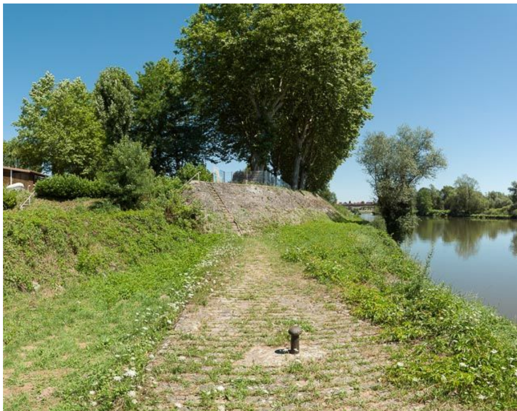
La Loire et le camping depuis le bajoyer.
