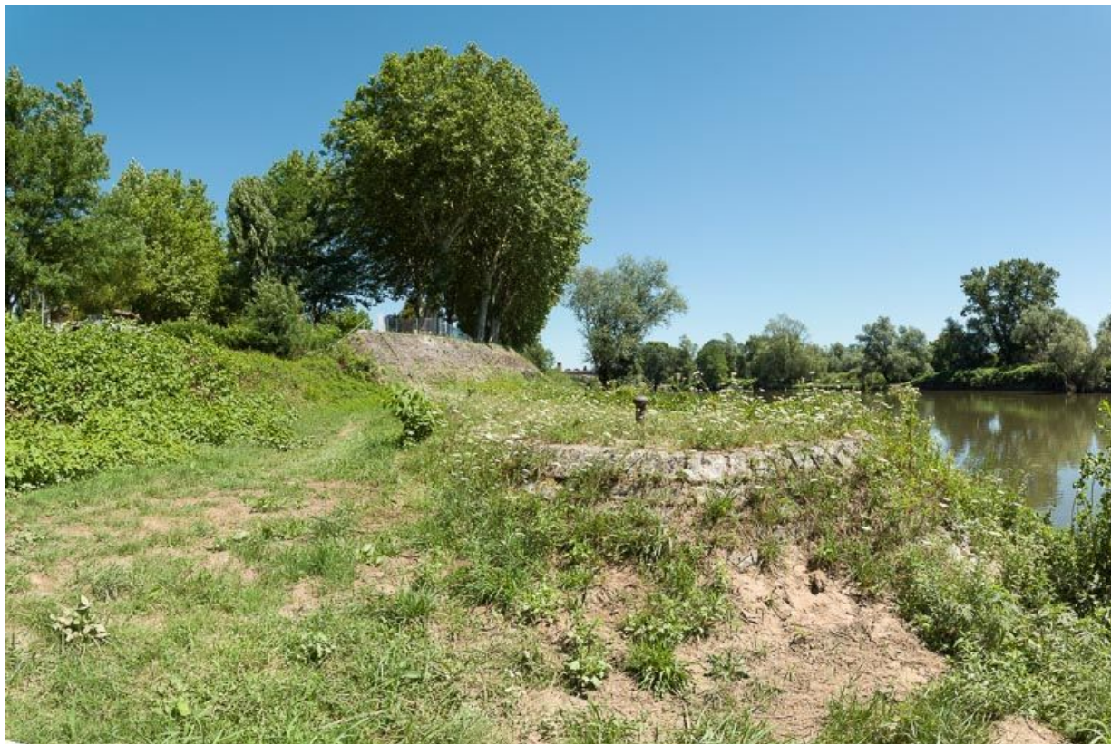
L'ancien bajoyer et la Loire.
